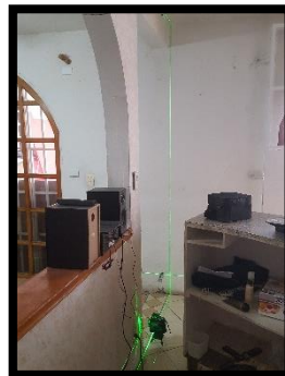
Revisión desplome de muros con nivel laser.
