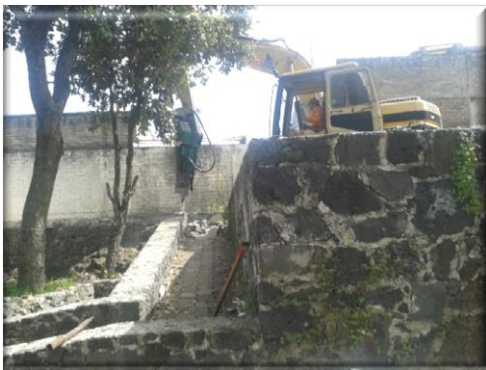
.Demolición de muros de mampostería.
