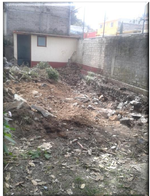
Desmantelamiento sala multiusos.
