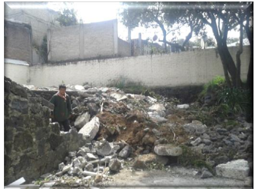
Desmantelamiento de centro de salud.
