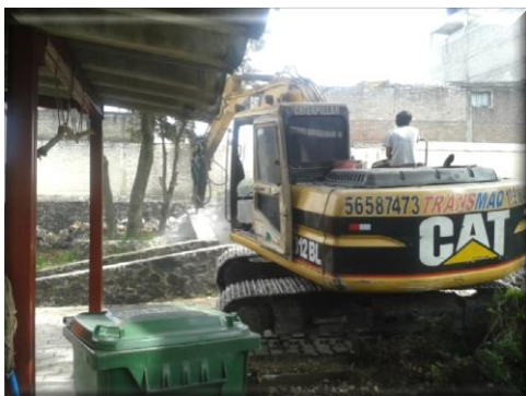
.Demolición de muros de mampostería.
