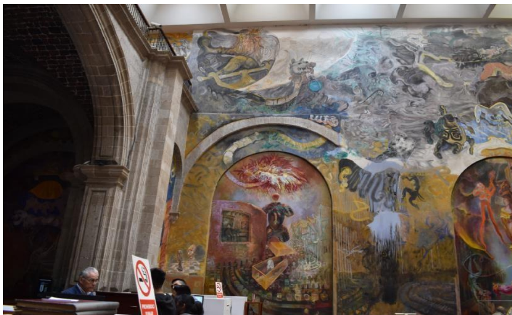
Imagen 2. Biblioteca Lerdo de Tejada. Detalle de mural y de las columnas del arco en el coro. Fotografía tomada el 05/03/20
