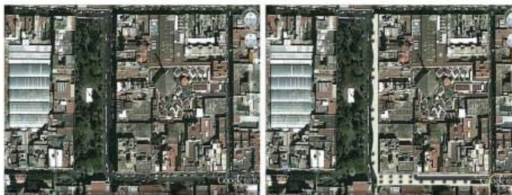
Estado actual en las calles centrales de la cabecera municipal de Texcoco.
