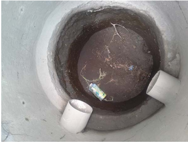
Anexo 6. Pozo de Infiltración.
