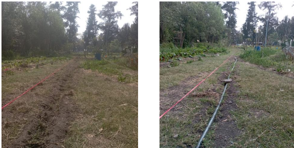
Figura 2. La zanja antes y después de tener la manguera de poliagua
