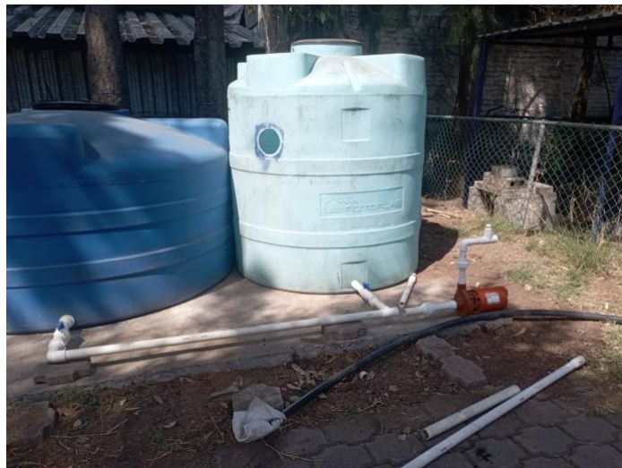
Fig.4. Colocación de los tubos Pvc
