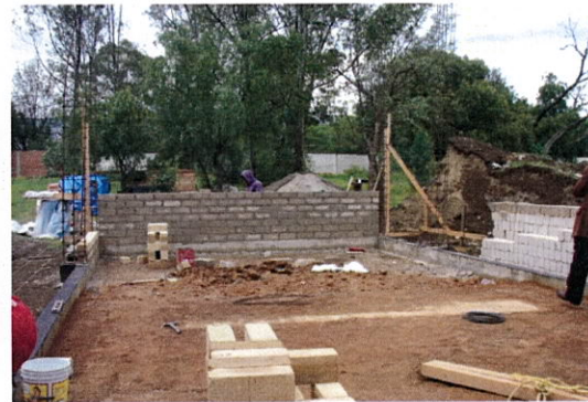
Construcción de muros
