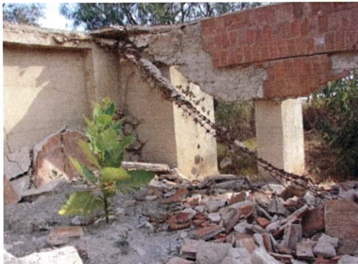
Refuerzos anclados en la trabe perimetral
