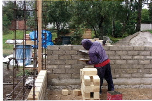
Construcción de muros
