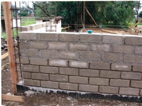
Levantamiento de muros
