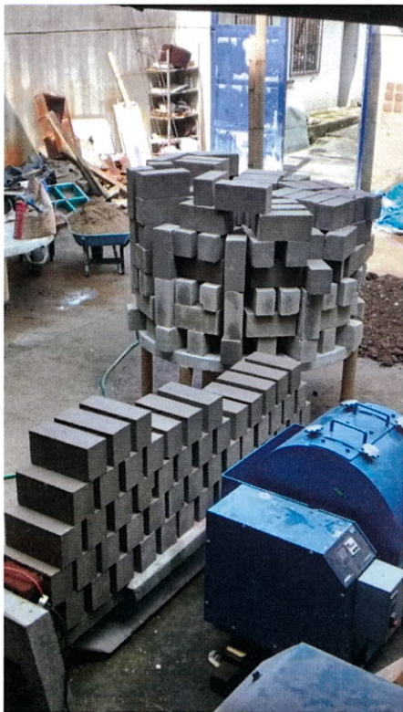
Elaboración de bloques
