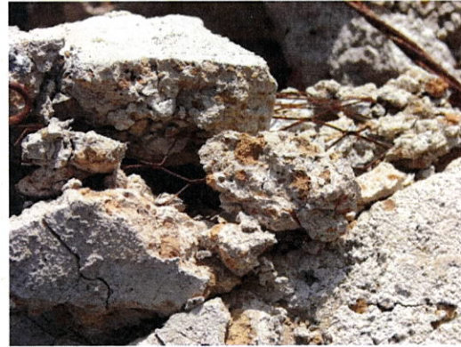
Techumbre colapsada
