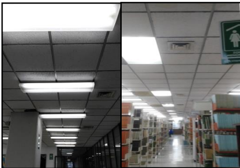
IMAGEN 3. Fue necesario contabilizar las luminarias y ductos de ventilación existentes en cada nivel
