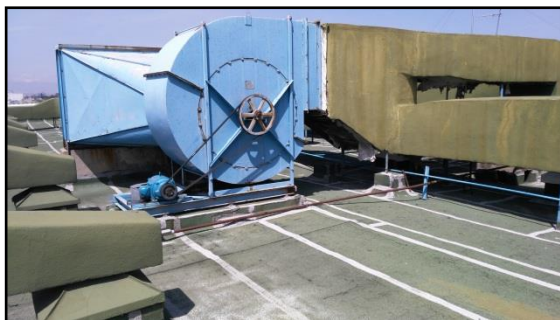
IMAGEN 9. Se realizó el levantamiento de todos los elementos necesarios para la ventilación del edificio.
