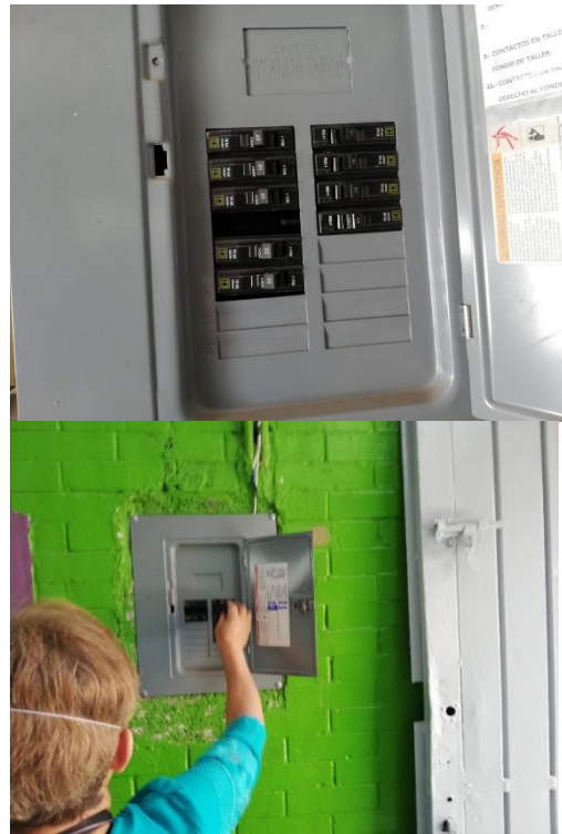
Imagen 4.- Levantamiento de instalaciones eléctricas
