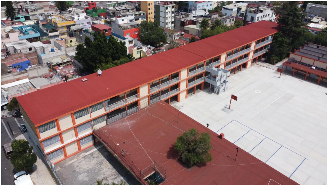
Imagen 5.- Edificio de aulas vista aérea
