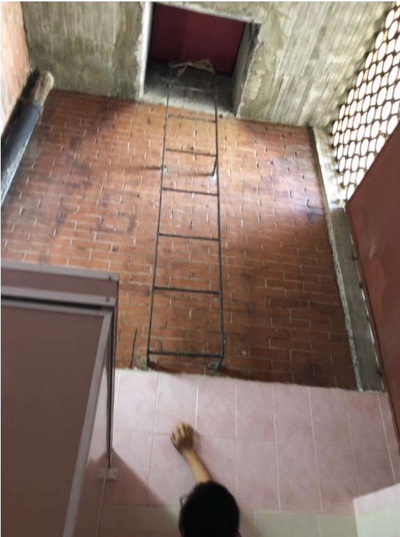
Imagen 3.- Levantamiento de instalaciones hidrosanitarias
