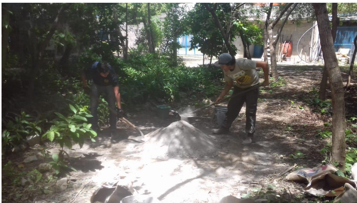
Figura 2: Mantenimiento de encierros, mediante la elaboración de material de construcción (mezcla de cemento, arena y grava).
