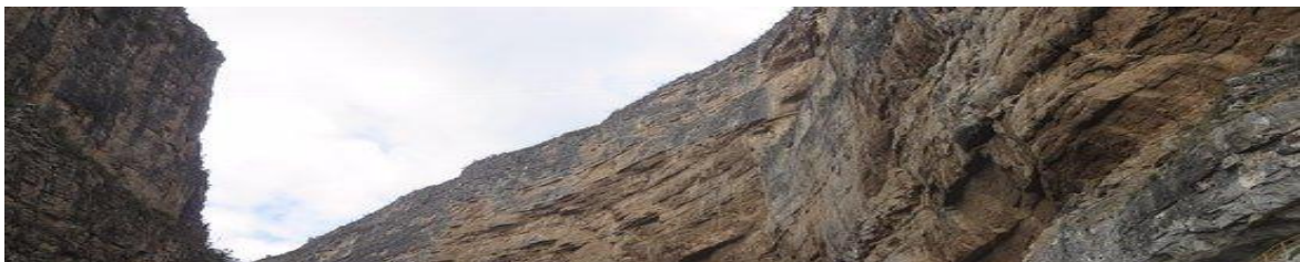
Presas hidroeléctricas "Fernando Hiriart Balderrama" y cañón de "El Infiernillo"
