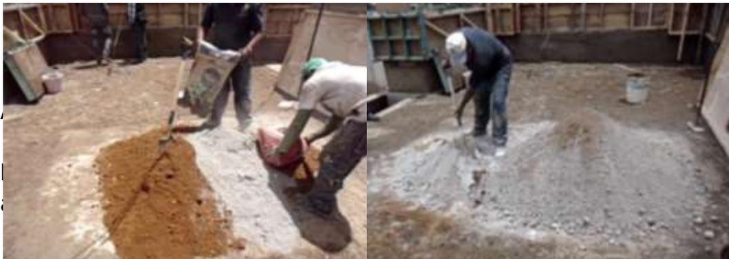
mezcla se le agrega agua y se revuelve hasta obtener una mezcla homogénea y manejable que se vacía dentro de una cimbra pre armada a manera de tapial.
