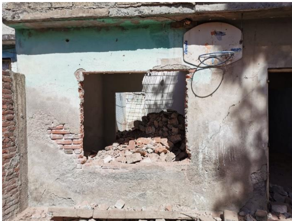
Imagen 61. Proceso de demolición de vivienda.
