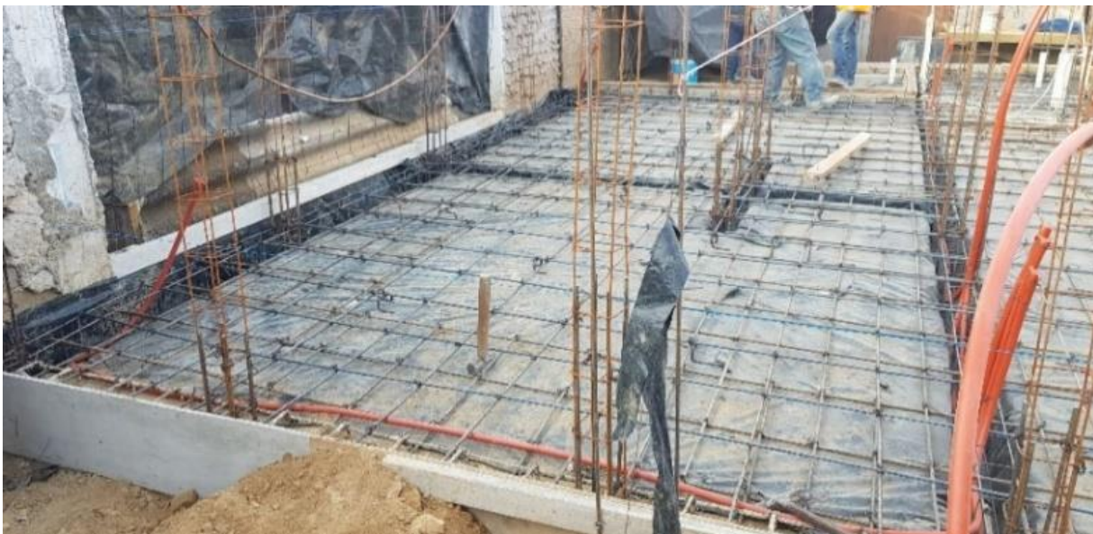
Imagen 68. Armado de losa de cimentación.
