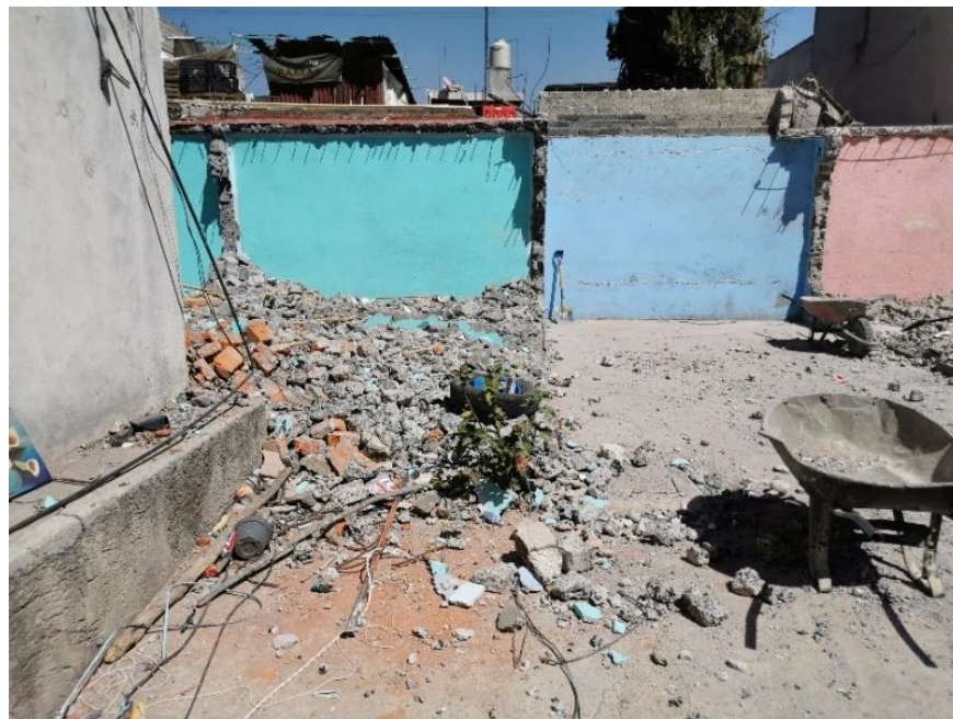
Imagen 54. Proceso de demolición de vivienda.
