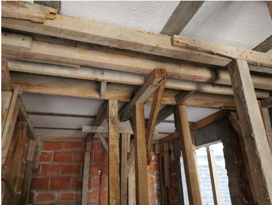
Imagen 37. Cimbra de losa de vigueta y bovedilla
