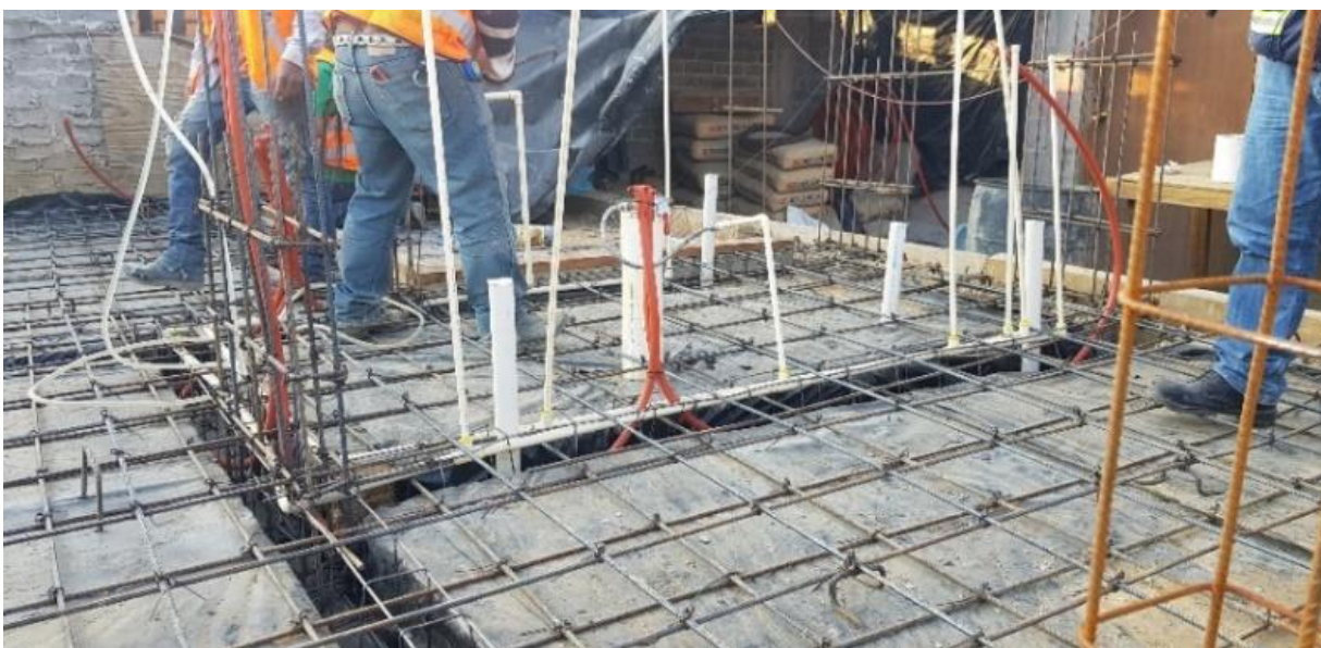
Imagen 69. Armado de losa de cimentación y colocación de tubos de instalaciones.
