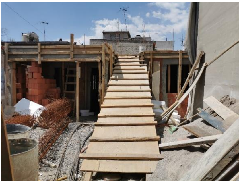
Imagen 52. Proceso constructivo de vivienda reconstruida.
