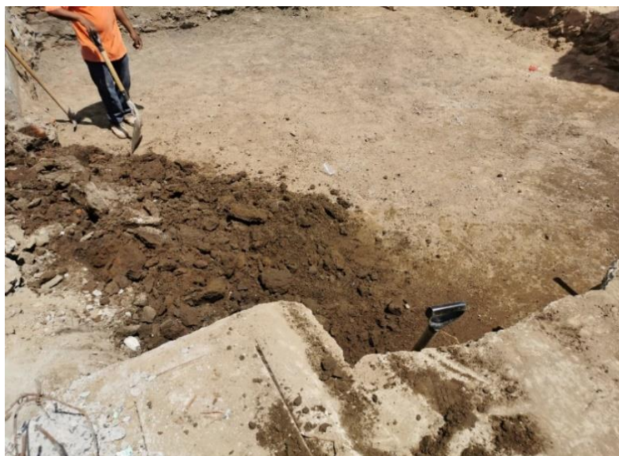
Imagen 57. Proceso de mejoramiento de terreno.
