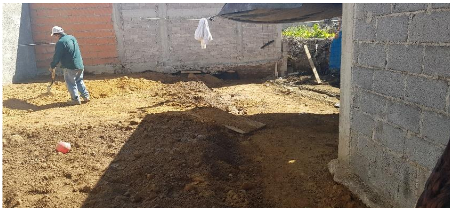
Imagen 42. Mejoramiento de Terreno
