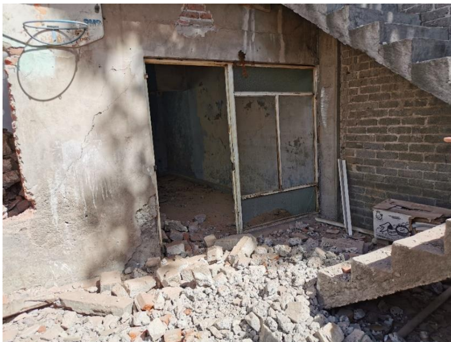
Imagen 62. Proceso de demolición de vivienda.
