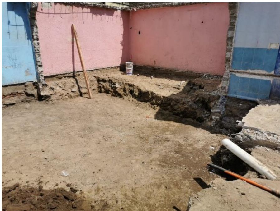
Imagen 56. Proceso de mejoramiento de terreno.
