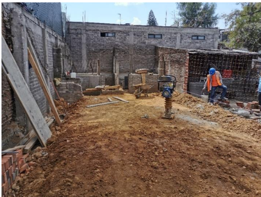
Imagen 65. Proceso de mejoramiento de terreno.
