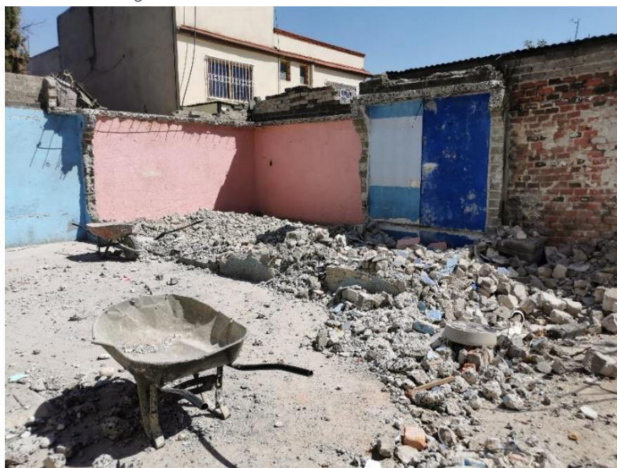
Imagen 55. Proceso de demolición de vivienda.
