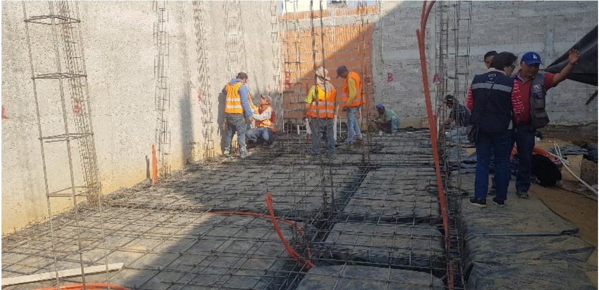
Imagen 43. Armado de losa de cimentación.
