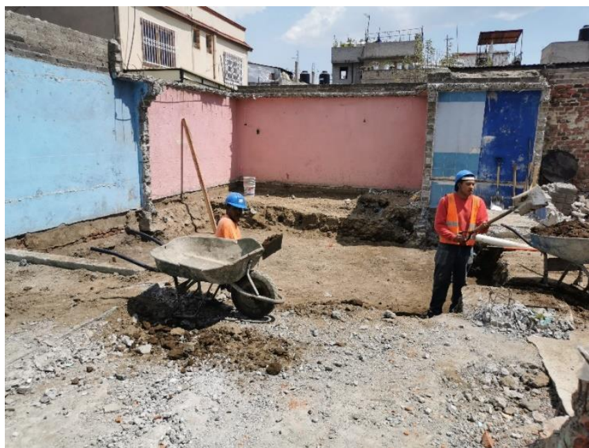
Imagen 59. Proceso de extracción de cimentación existente.
