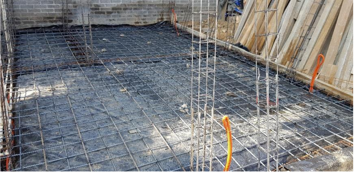
Imagen 34. Armado de losa de cimentación.
