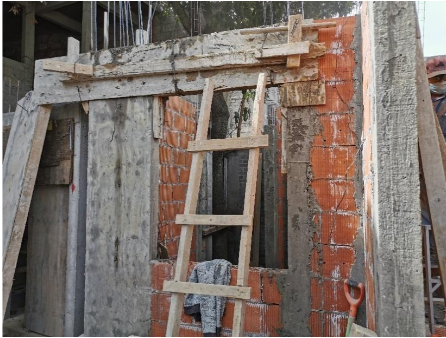
Imagen 38. Confinamiento de vano de ventana
