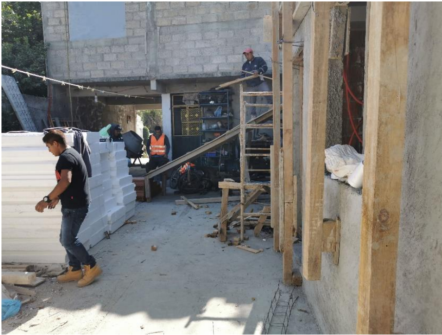
Imagen 36. Vista de materiales.
