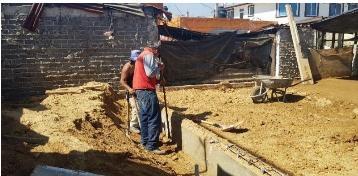
Imagen 66. Extracción de cimientos existentes.
