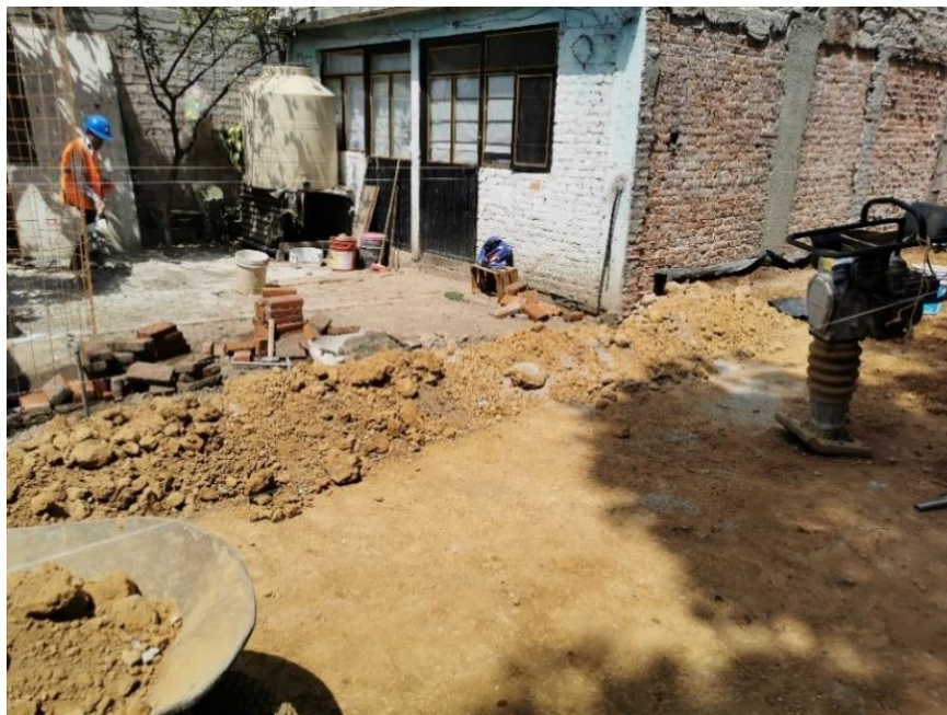
Imagen 64. Proceso de mejoramiento de terreno.
