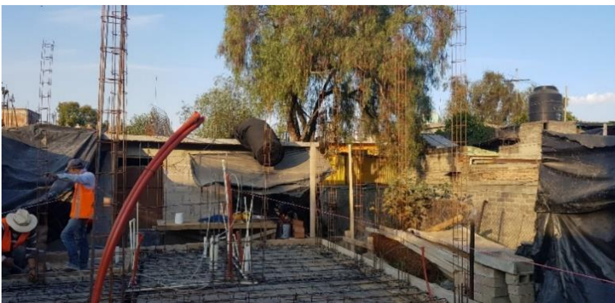
Imagen 67. Armado de losa de cimentación.
