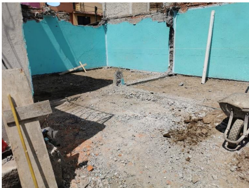
Imagen 58. Proceso de extracción de cimentación existente.
