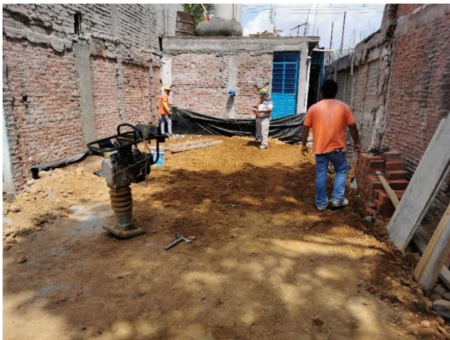
Imagen 63. Proceso de mejoramiento de terreno.
