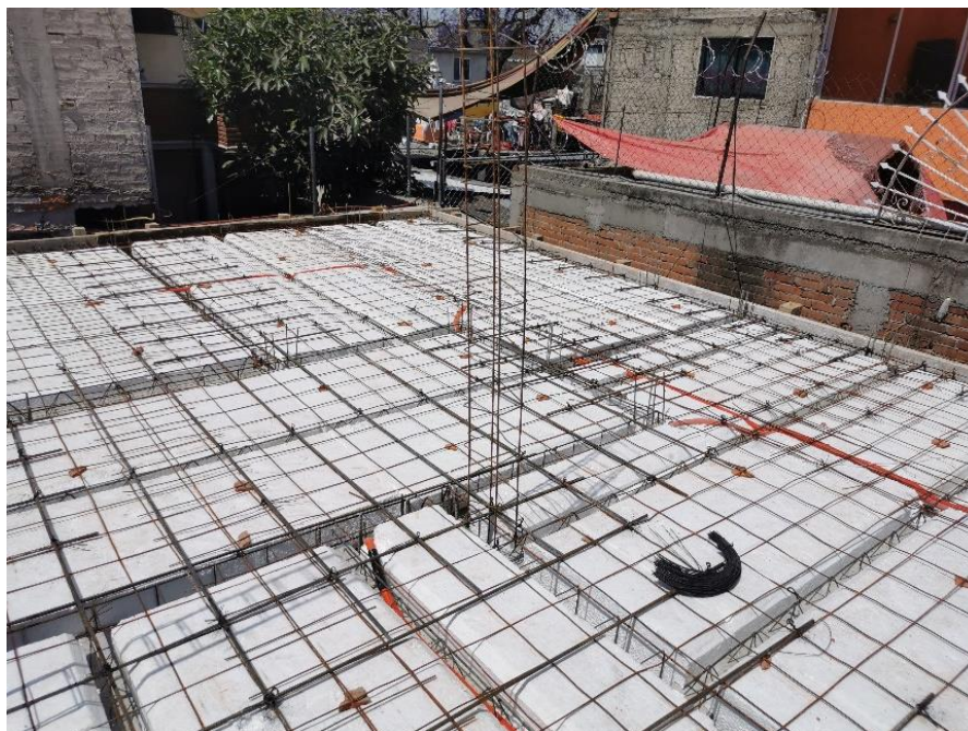
Imagen 53. Losa de azotea de vigueta y bovedilla con malla electro soldada.
