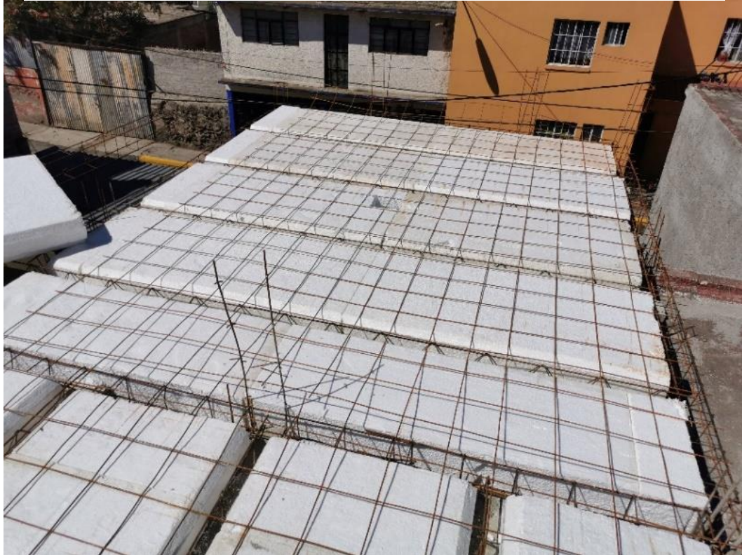
Imagen 44. Losa de azotea de vigueta y bovedilla con malla electro soldada.
