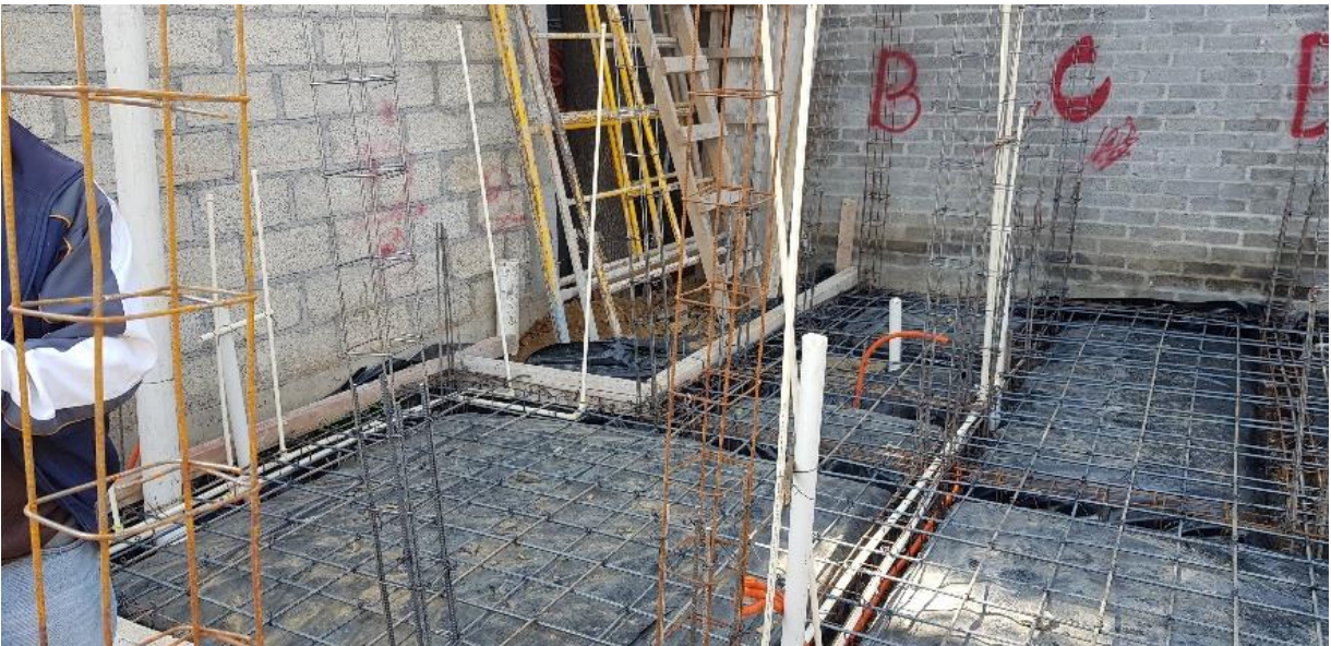
Imagen 35. Armado de losa de cimentación con instalaciones
