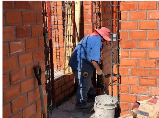
Imagen 14: Colocación de novablock multiperforado para muros interiores en proyecto Manzana 25 (2023).
