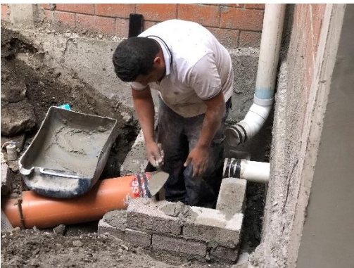
Imagen 11: Elaboración de registros sanitarios y conexión de tuberías para desagüe de aguas negras. Proyecto Manzana 25 (2023).
