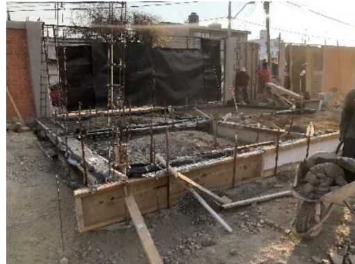
Imagen 18: Colado de contratrabes para cimentación en depósito de basura. Proyecto Tlaxilacalli (2023).
