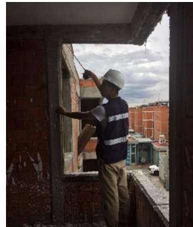
Imagen 20: Levantamiento arquitectónico en obra.
