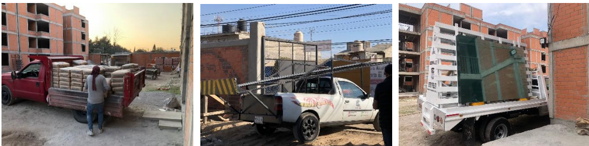
Imagen 5: Entrega de diferentes materiales como bultos de cemento, perfiles metálicos y hojas de cristal para trabajos de albañilería, herrería y cancelería.
