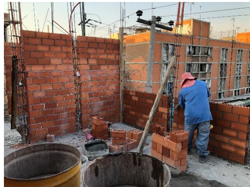
Imagen 10: Levantamiento de muros con novablock multiperforado. Proyecto Manzana 25 (2023).
