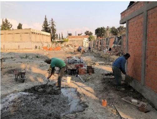
Imagen 17: Elaboración de mezcla en obra para trabajos de albañilería. Proyecto Tlaxilacalli (2023).
