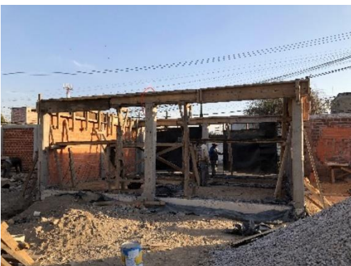
Imagen 19: Colado de trabes para depósito de basura. Proyecto Tlaxilacalli (2023).
