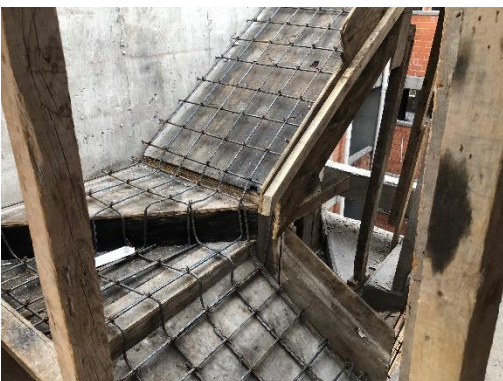
Imagen 13: Armado de acero para refuerzos estructurales de escalera. Proyecto Manzana 25 (2023).
