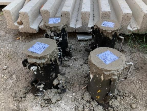
Imagen 15: Toma de muestras de concreto para pruebas de compresión en laboratorio. Proyecto Manzana 25 (2023).
