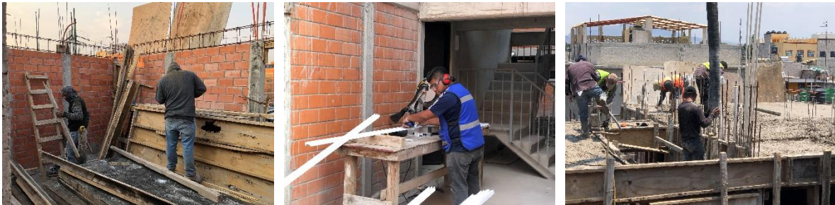
Imagen 6: Supervisión de trabajos de encajonamiento para colado de trabes y cerramientos, habilitado de perfiles metálicos para cancelería y colado de losa del edificio 11, 3er nivel en proyecto Manzana 25.
