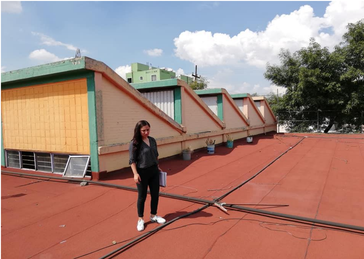
Imagen 4: Tomando medidas de las cubiertas del edificio de talleres, 2019
