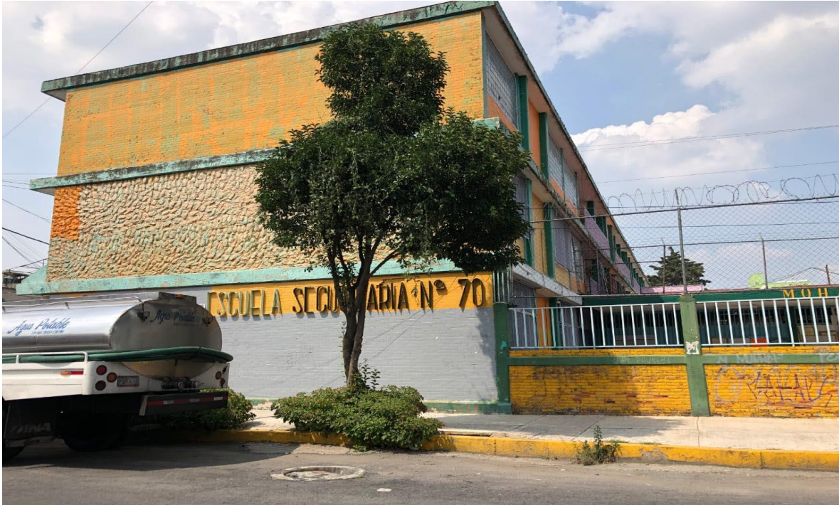
Imagen 1: Fachada principal de la Escuela Secundaria General No. 70 "Mahatma Mohandas K. Gandhi", 2019
