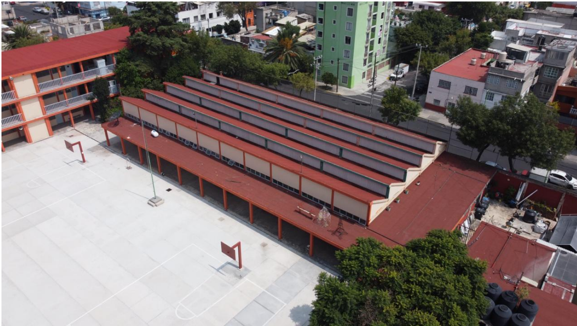
Imagen 6: Foto aérea del edificio de talleres de la Secundaria, 2020
