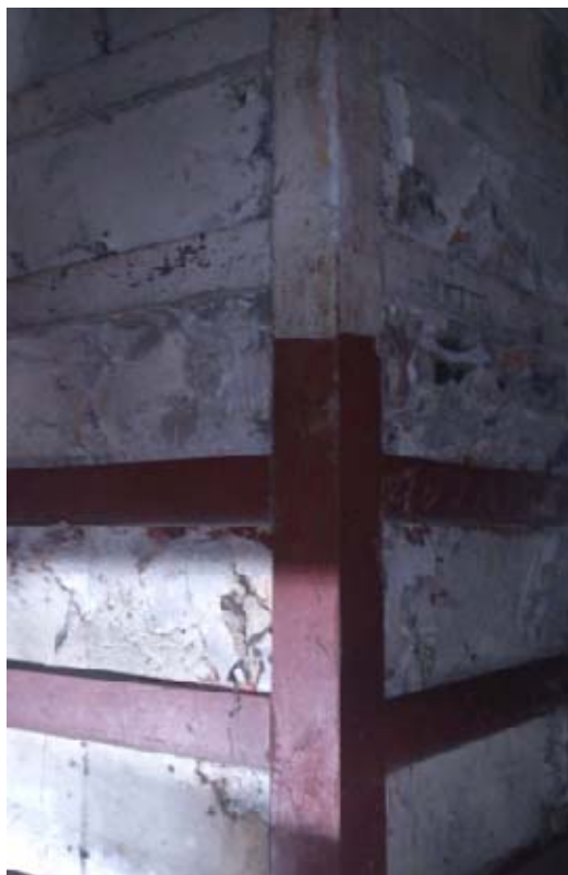
Las columnas están reforzadas con zunchos metálicos para contrarrestar los esfuerzos de carga.
