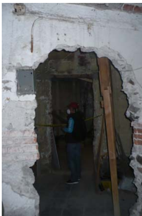
Apertura descuidada de vanos en muros,
