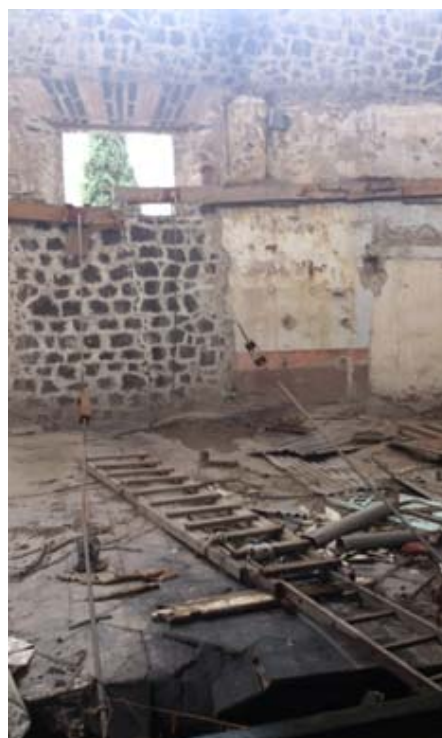
Apertura descuidada de vanos en muros,
