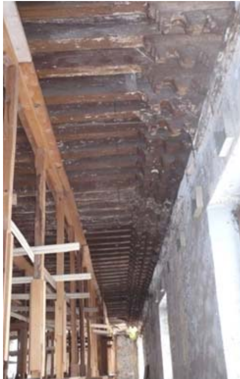
Puntales que soportan el entrepiso
