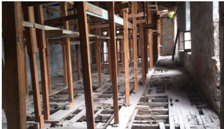
El primer nivel muestra puntales que soportan el techo
