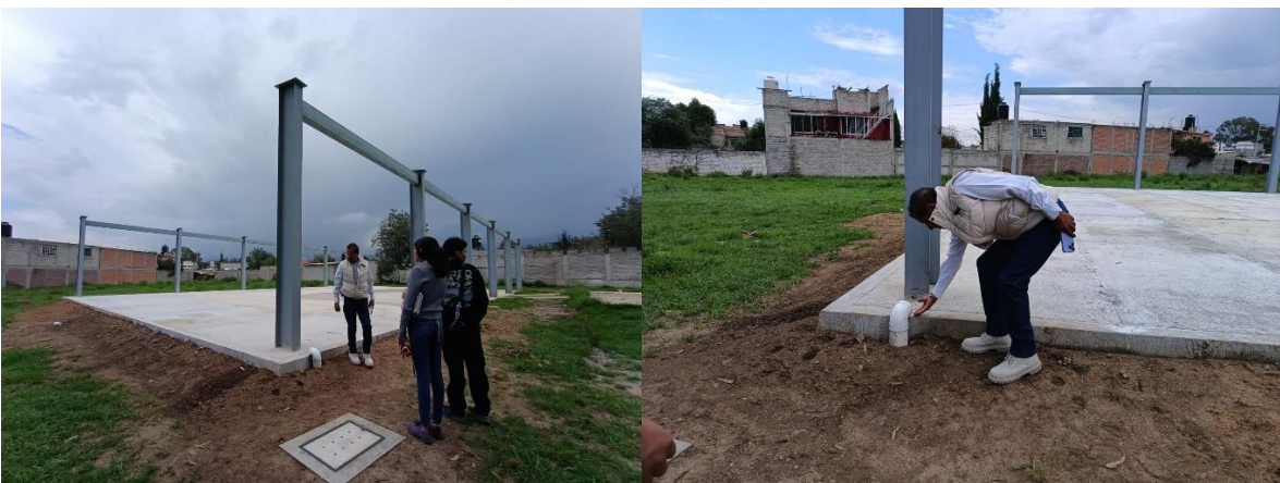
Techado en áreas de educación física, cepas de cimentación y armado de zapatas. Fotografías tomadas por Sandra Jimena Juárez Aguilar.
