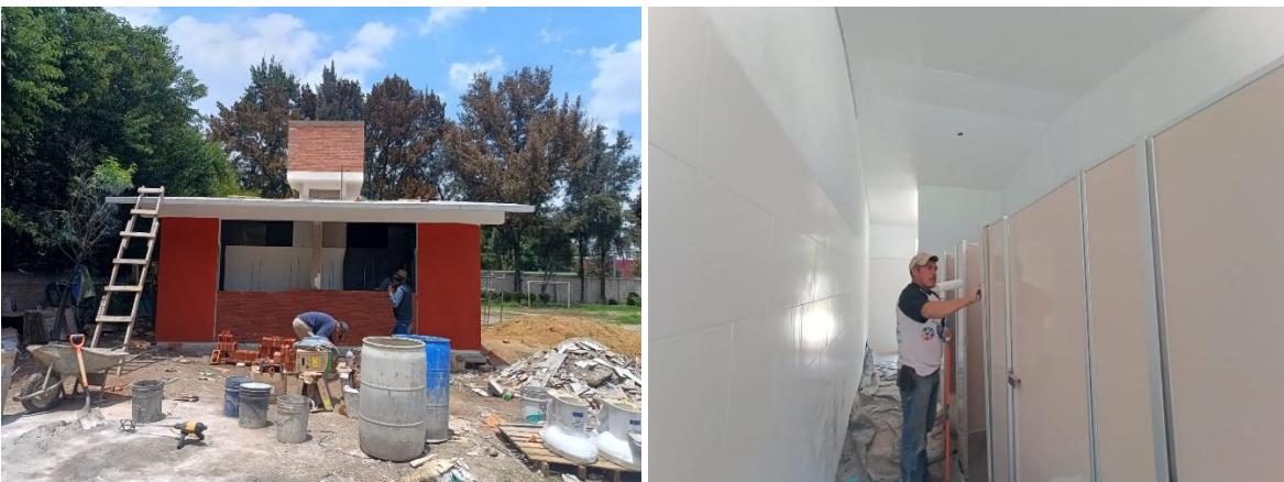
Construcción de módulos sanitarios. Fotografías tomadas por Sandra Jimena Juárez Aguilar.
