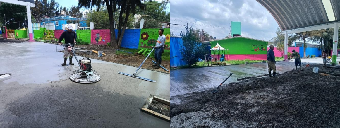
Construcción de firme de concreto. Fotografías tomadas por Sandra Jimena Juárez Aguilar.
