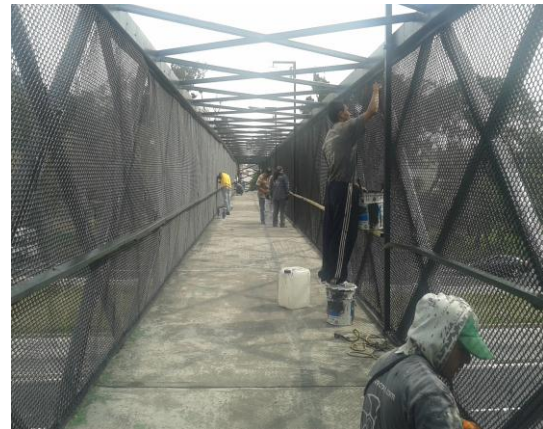
Puente Prepa 9-Insurgentes Norte y Calle Ricarte: aplicación de pintura en jaula.
