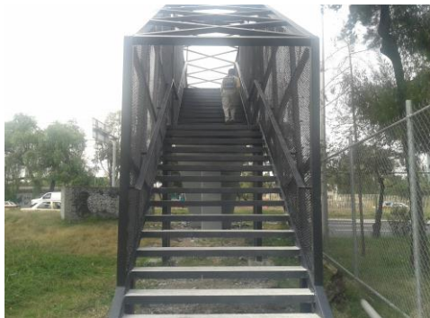
Puente Prepa 9-Insurgentes Norte y Calle Ricarte: restitución de escalones.
