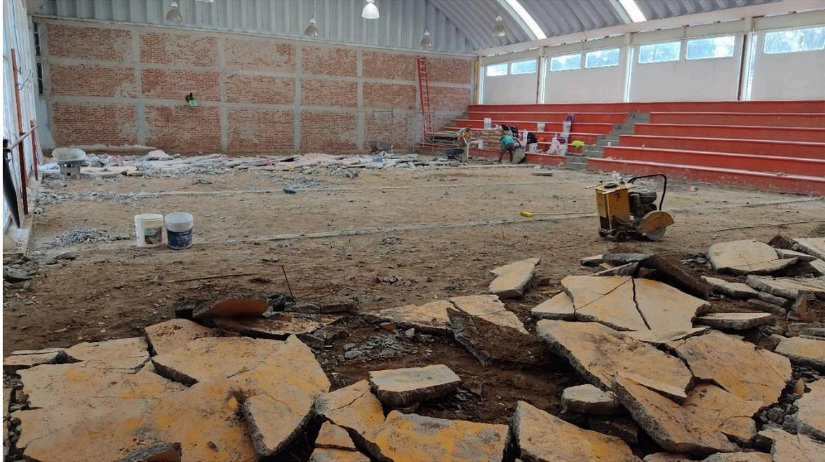
*Retiro del aplanado del muro para verificar integridad*
