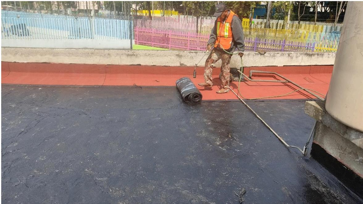
*Colocación de impermeabilizante prefabricado*
