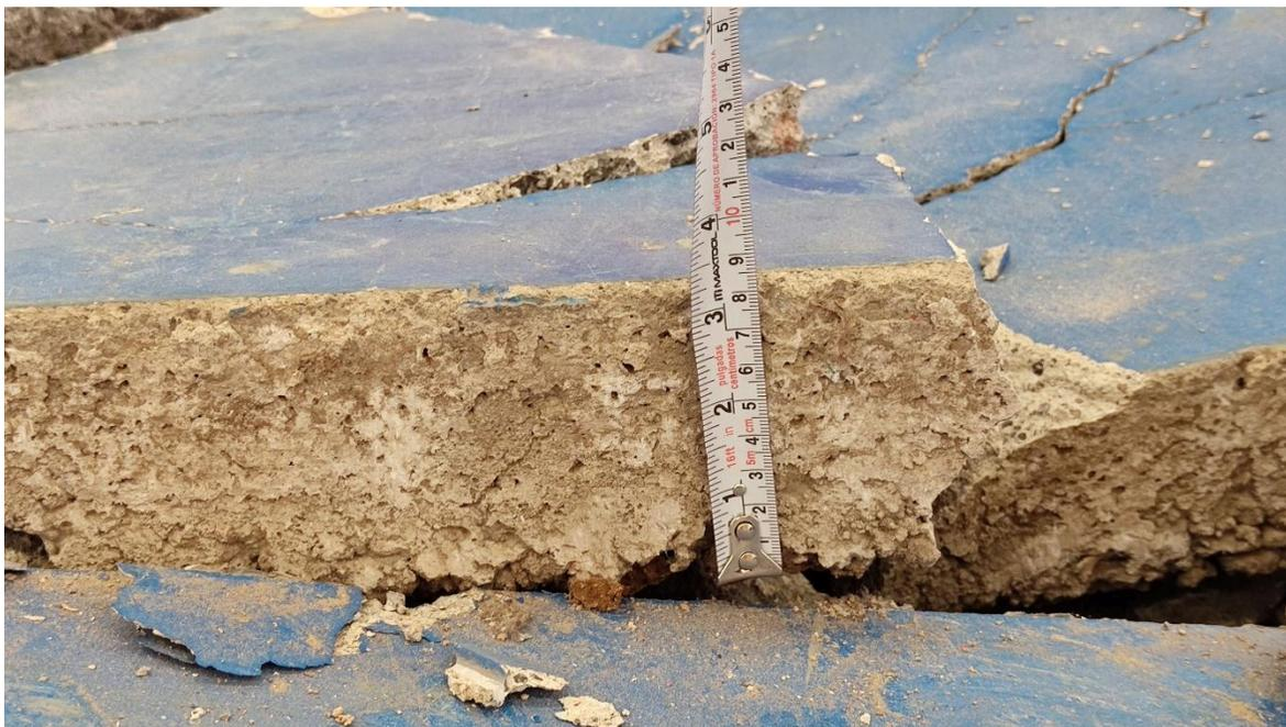
*Se verifica el espesor del firme, de 8 a 10*
