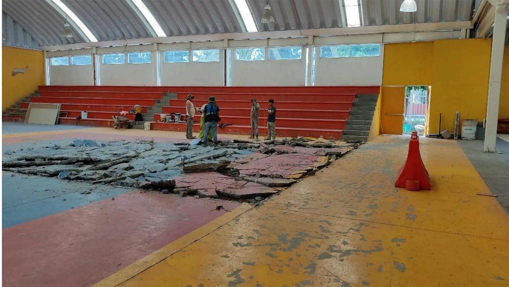
*Demolición por medios manuales de firme de concreto*
