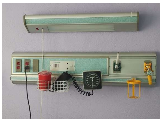
Imagen 42. Unidad de succión de pared
