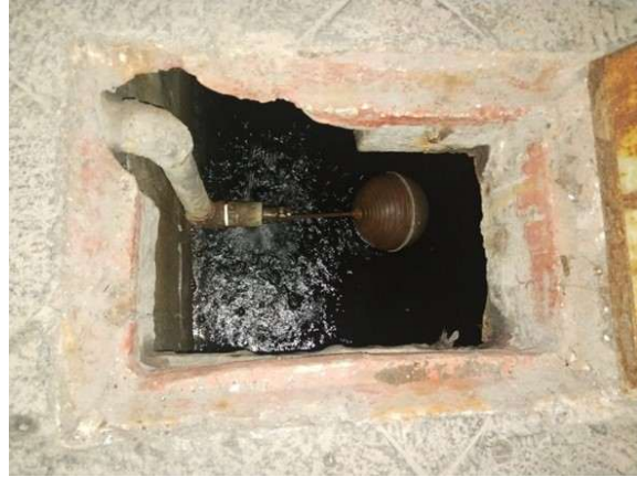
Imagen 34. Cisterna 2. Ubicada junto a la calle 20 de Noviembre.
