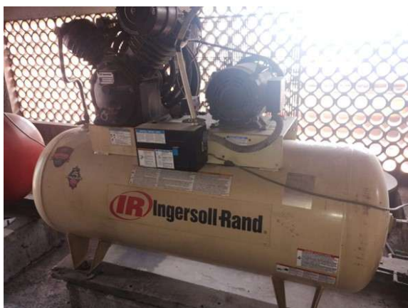
Imagen 39. Compresor de aire medicinal
