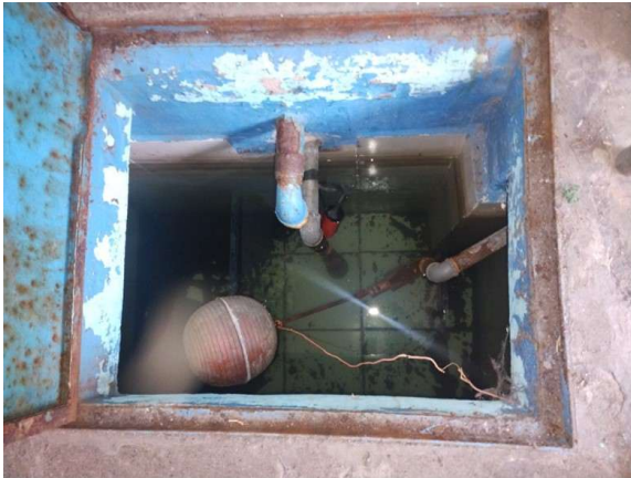
Imagen 33. Cisterna 1. Ubicada junto a la calle de Mesones
