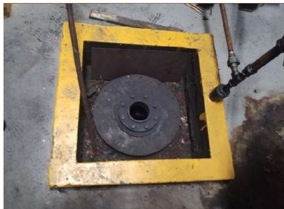
Imagen 26. Depósito de 10000 litros diésel
