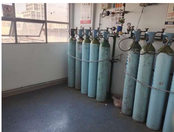
Imagen 41. Gases Medicinales (Manifold)
