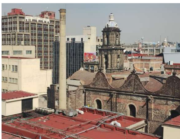
Imagen 32. Chimenea de las calderas
