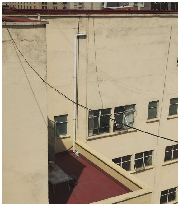
Imagen 37. Bajada de Aguas Pluviales
