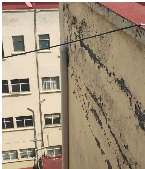
Imagen 38. Instalaciones en Fachadas
