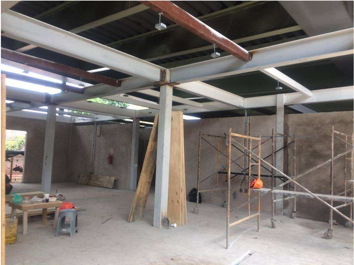
Fotografía No 2. Visita de obra en la Territorial Tasqueña, supervisión en la colocación de vigas intermedias
