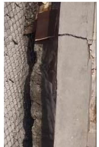
Muro recargado en lindero poniente.
