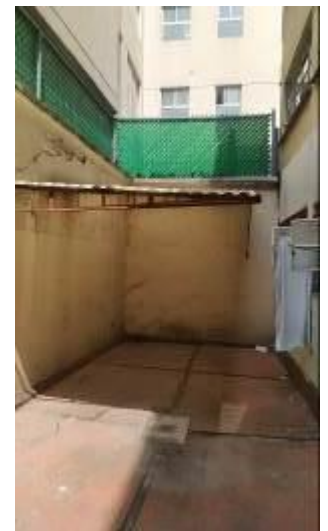
Cajón de estacionamiento con techumbre de acero.
