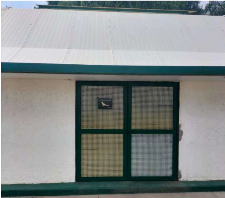
Figura 9. Exterior del Área de pericos internos.
