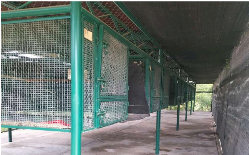
Figura 4. Interior del Área de pericos externos
