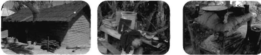
Imagen 4. Condiciones de vivienda y sanidad en las comunidades Me Phaa.
