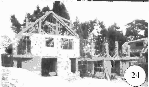
21 a 24: Momentos de construcción Inaia Súe. 1995
