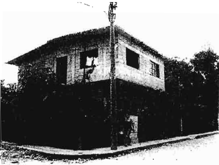
Ejemplo de casa construida varios años después de la inundación.
