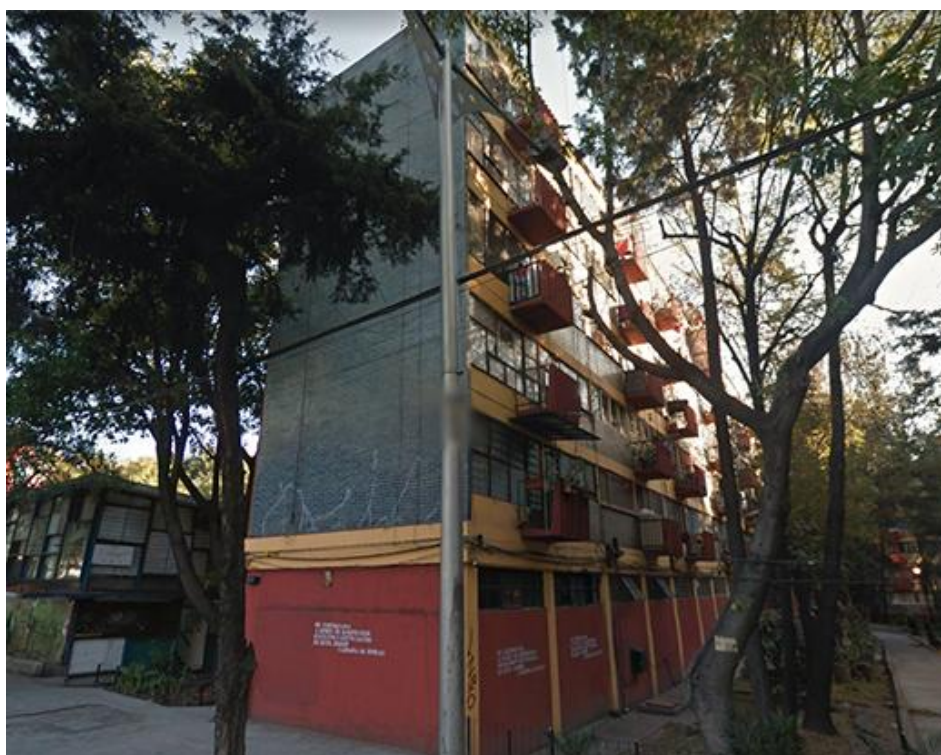
Figura 4.16. Edificio 1C del Multifamiliar Tlalpan antes del sismo 19s17
