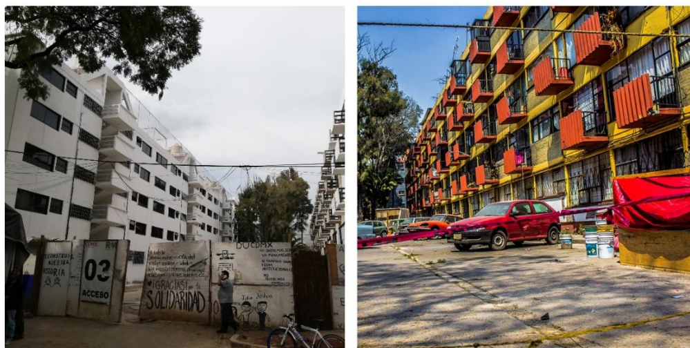
Figura 4.15. Comparación del Multifamiliar Tlalpan antes y después de la reconstrucción
