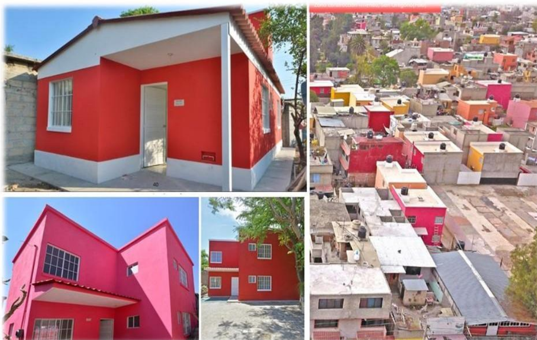
Figura 3.4. Viviendas reconstruidas por la Fundación Slim–Proviváh en San Gregorio Xochimilco
