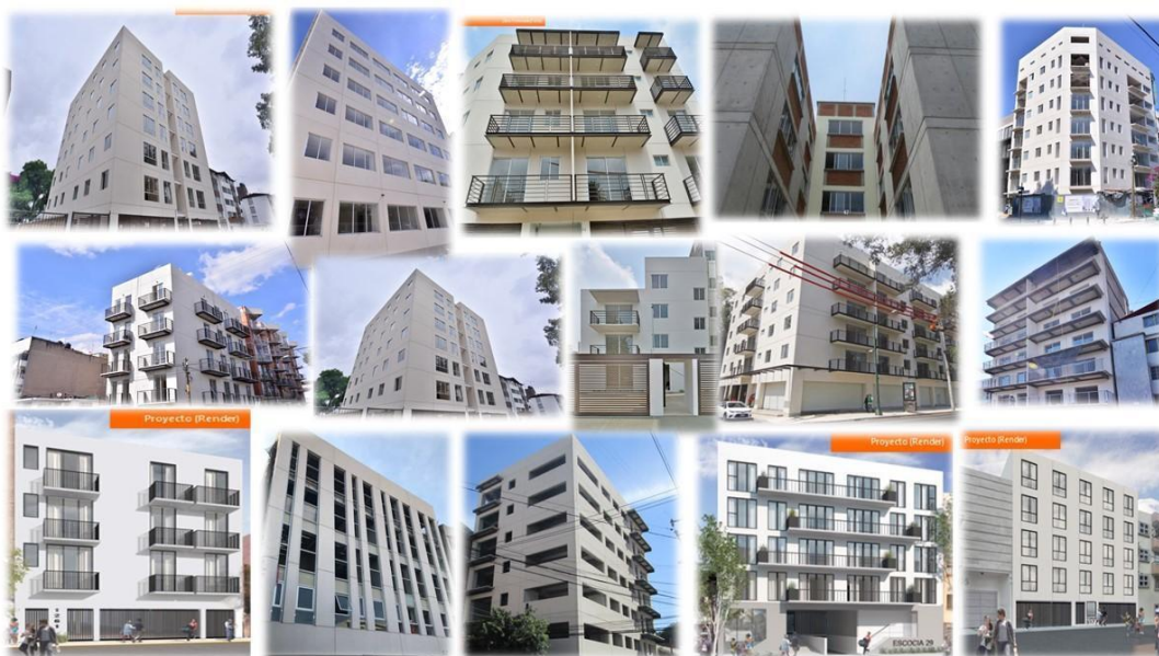
Figura 3.10. Multifamiliares reconstruidos por la Fundación Slim en la Ciudad de México
