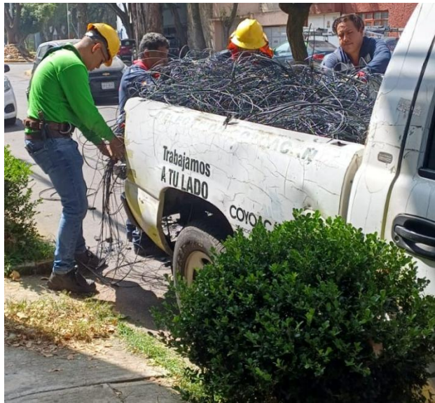
Imagen 4. Ruta de retiro de cableado
