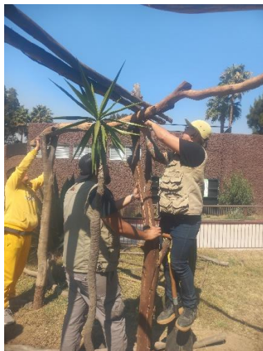
Figura 13. Se fijaron todas las perchas a la estructura y los troncos que sostendrían la hoja de palma fijándolos con alambre. Foto tomada por: (Gómez, 2023)
