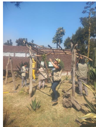
Figura 13. Se fijaron todas las perchas a la estructura y los troncos que sostendrían la hoja de palma fijándolos con alambre. Foto tomada por: (Gómez, 2023)
