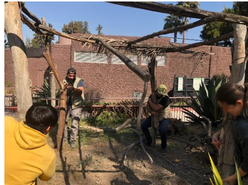
Figura 11. Se le quitó toda la hoja de palma al recinto y se aflojó la tierra para sacar la estructura de la tierra. Foto tomada por: (Gómez, 2023)
