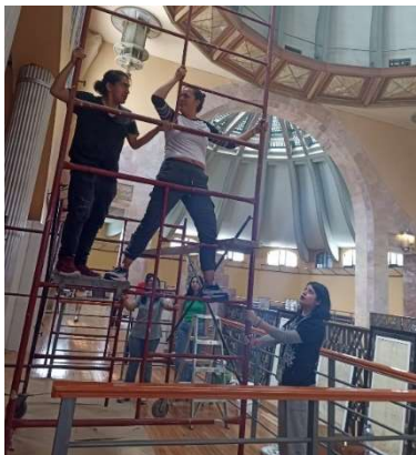
IMAGEN 7. Armado de andamios, foto tomada por Ximena Flores, Agosto 2024.
