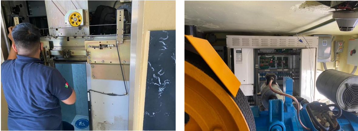
Fotografías tomadas durante el proceso de mantenimiento.
