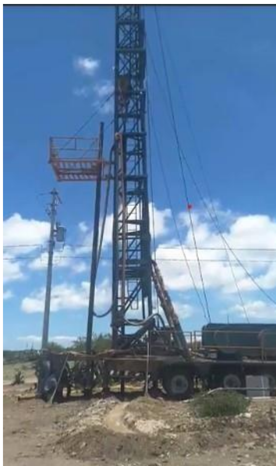
Figura 12. Perforación de pozo para ampliación de la red.
