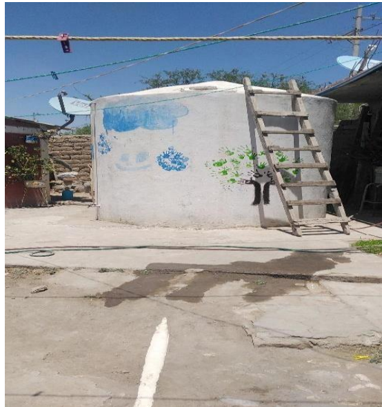
Figura 13. Cisterna de ferrocemento recolectora de agua de lluvia.
