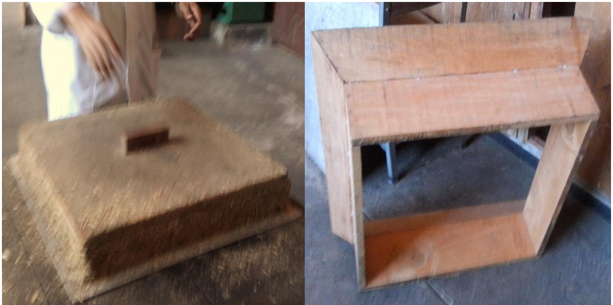
Retiro del encofrado
