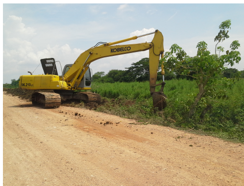
Figura 37: “La catapila”: Máquina abriendo zanja para jarillón en Ciénaga de Oro
