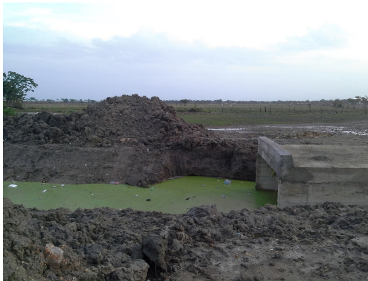
Figura 11: Obra de canalización de los cuerpos de agua para la desecación de los terrenos comunales
