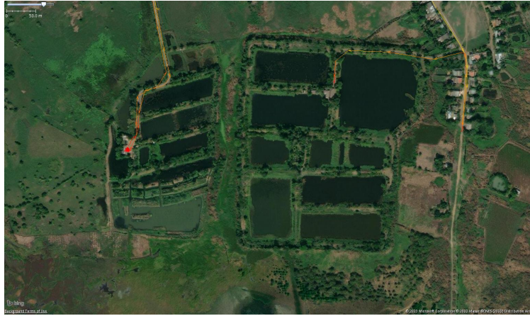
Figura 75: Vista aérea de la sede de APROPAPUR
