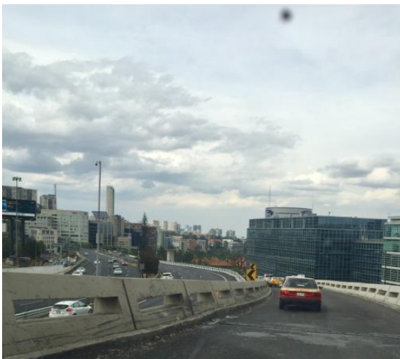
Fotografía 17 Vía y borde.
