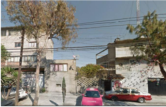
Fotografía 15 Fachada de la casa del Sr. R.
