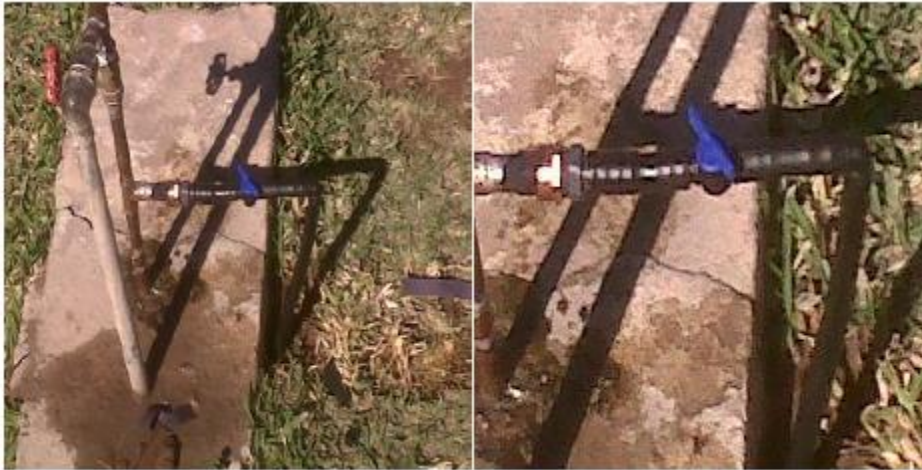
Figura 5: Conexión de codos y llave de paso.
