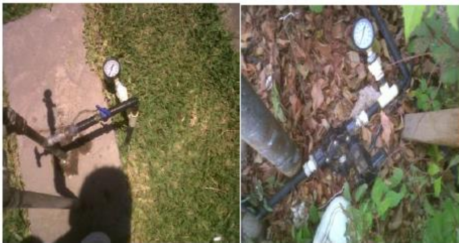
Figura 6: Conexión de manómetro y válvula eléctrica.
