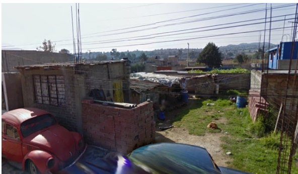
Ilustración 6. Construcción actual en la comunidad Tezontitla.
