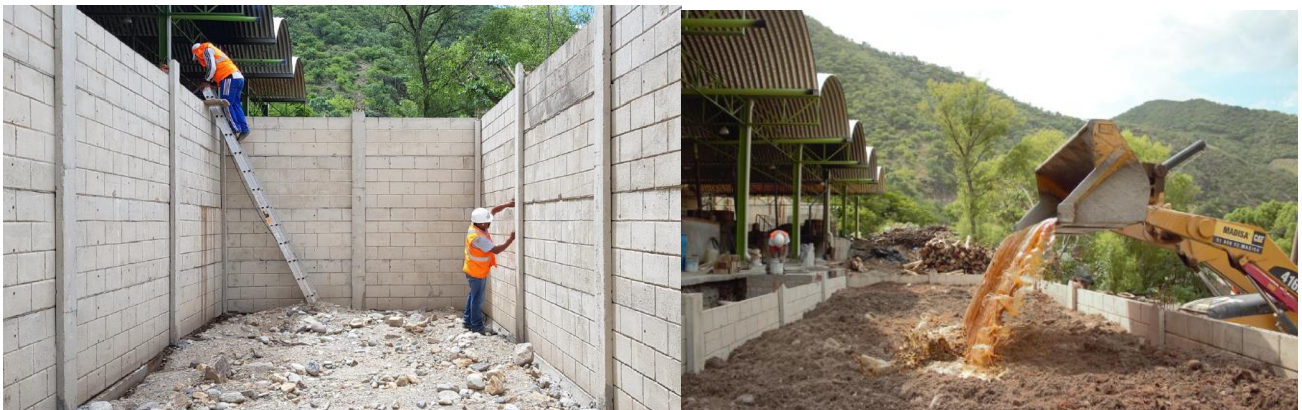
Foto 5: Proceso de construcción de bloque de tierra de 18 metros x 4 metros x 3.60 metros de alto donde se utilizaron 150,000 litros de vinaza y 100 toneladas de bagazo. Fuente: Archivo propio.
