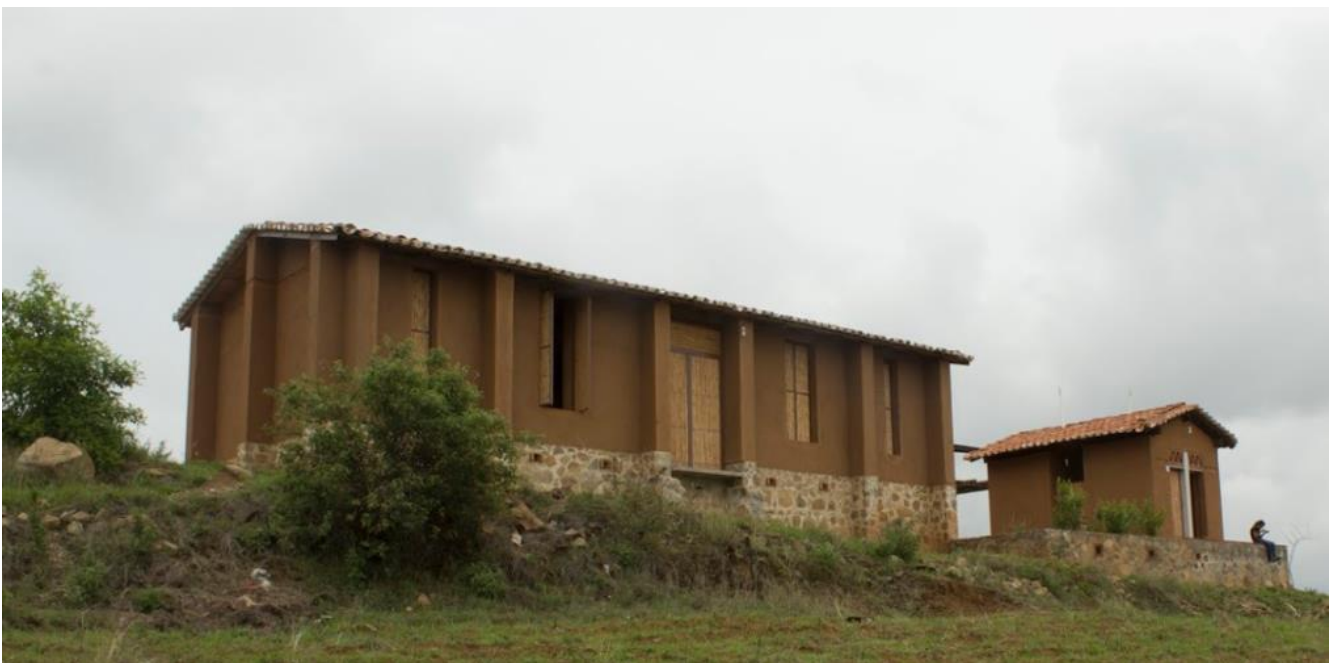
Foto 1: Biblioteca El Rosario , construcción realizada con adobe y residuo del mezcal, aplicación de propuesta sismorresistente. Fuente: Archivo propio.
