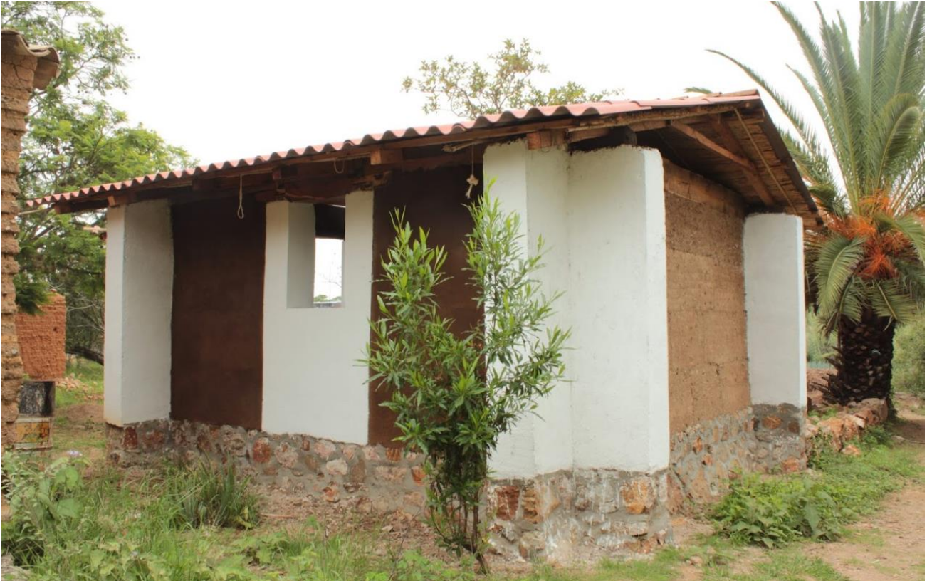
Foto 4: Prototipo construido. Fue posible utilizar 4,000 litros de vinaza para la construcción y 4 m3 de bagazo. La técnica de tierra compactada permitió construir los muros del prototipo en una semana. No fue requerida agua para la construcción de los muros. Fuente: Archivo propio.
