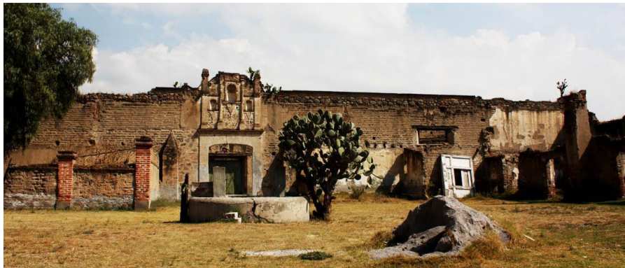
Figura 1. Patio interno de ex hacienda de San Francisco Acuautla
