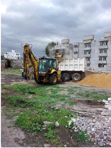
Imagen 11. Retiro de escombros.
