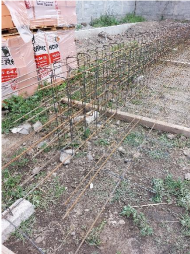
Imagen 13. Armado de zapata.
