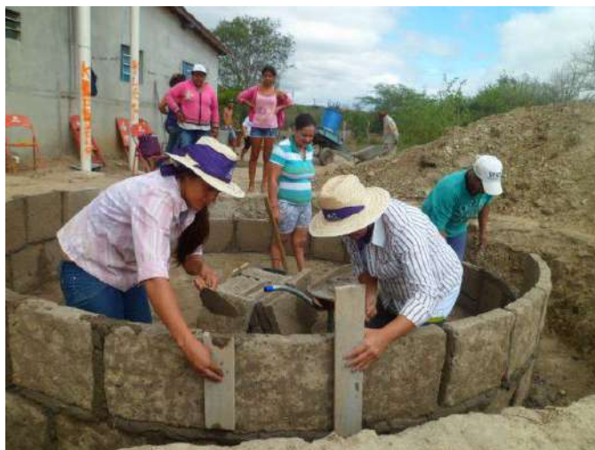
Figura 2. Mujeres pedreiras construyendo cisternas
