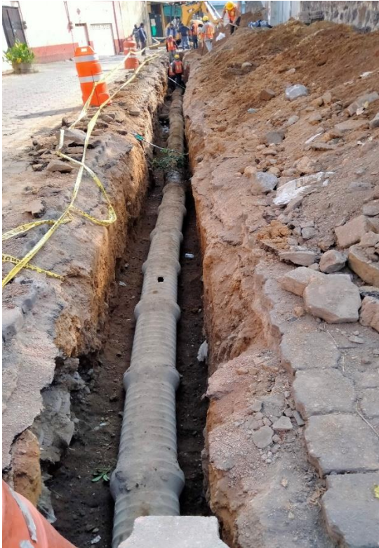
Excavación de zanja
