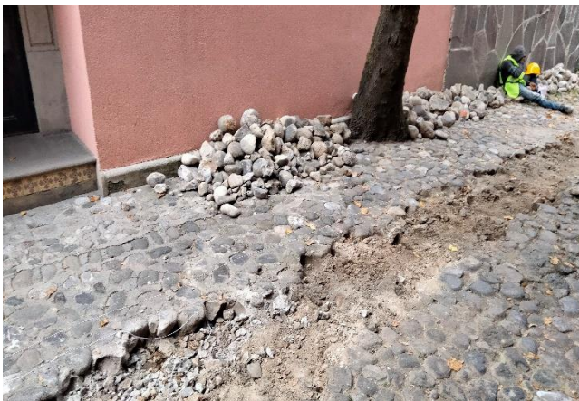
Retiro de piedra bola
