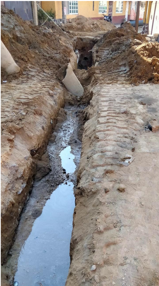
Excavación de zanja
