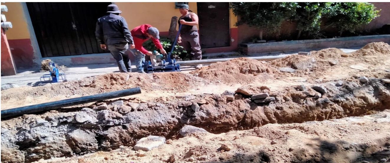
Termofusión de tubería de agua potable de 4”
