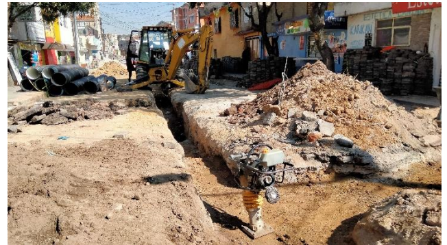
Compactación de zanja con bailarina
