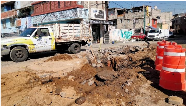
Reparación de fuga
