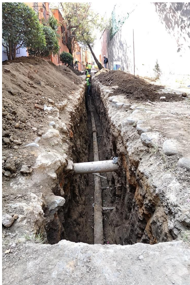
Excavación de zanja para la instalación de tubería de agua potable
