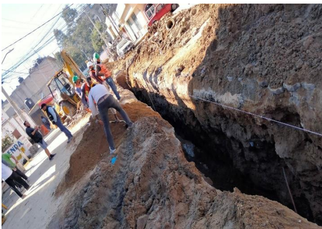
Relleno de tepetate
