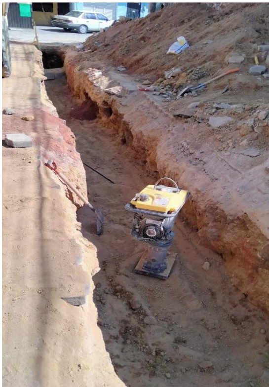
Compactación a dos capas
