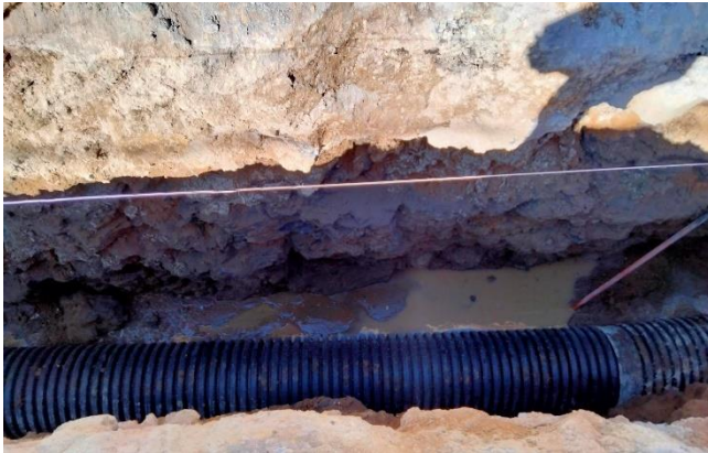
Bajada de tubería
