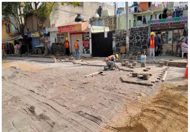
Colocación y nivelación de adoquín
