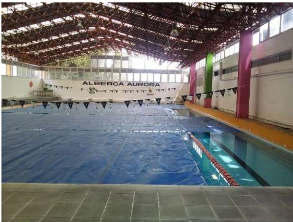
Foto 1.- Frente: Alberca "Aurora" Interior de la Alberca, antes de comenzar los trabajos de remodelación Fuente: Elaboración Propia
