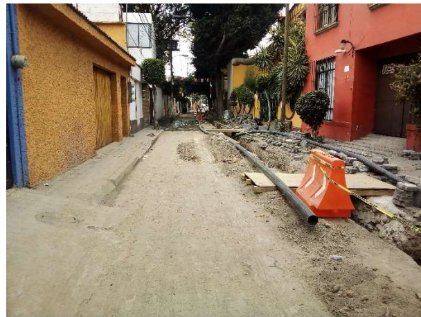
Foto 8.- Frente: “Real de San Lucas” Tendido de la red hidráulica en tubo de polietileno, en la Av. Real de San Lucas. Fuente: Elaboración Propia
