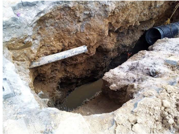
Foto 6.- Frente: “Las Flores”, Tubería de agua y drenaje en la misma línea, en calle de Las Flores, primero se reparará la línea de drenaje y después la de agua. Fuente: Elaboración Propia
