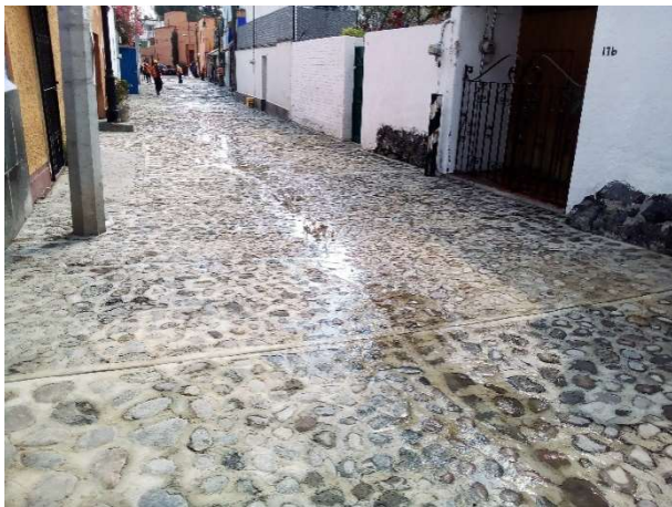
Foto 5.- Frente: Comité 03-106 Barrio de “Santa Catarina” En la imagen se aprecia la calle de Artes, recién terminada. Fuente: Elaboración Propia
