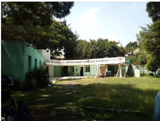
Foto 9.- Frente: Centro Comunitario “Francisco I. Madero” Fachada principal del centro comunitario, foto tomada después de realizar el programa de necesidades. Fuente: Elaboración Propia
