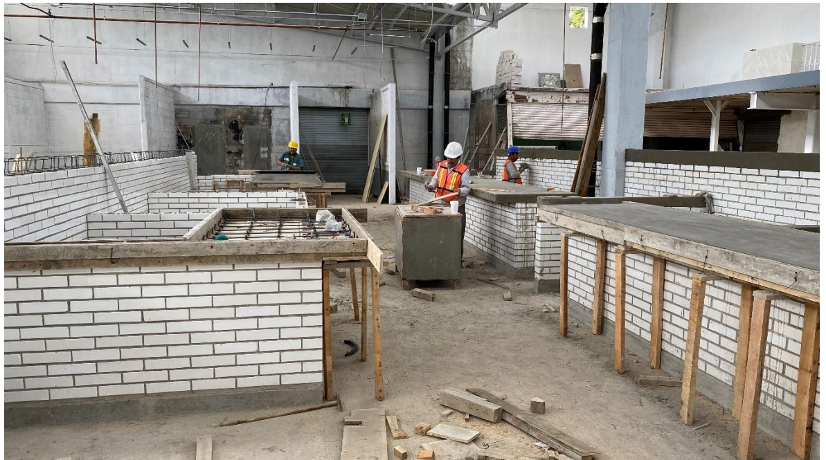
Imagen 2: construcción de mesetas a base de concreto armado para los locales del Mercado San Cosme
