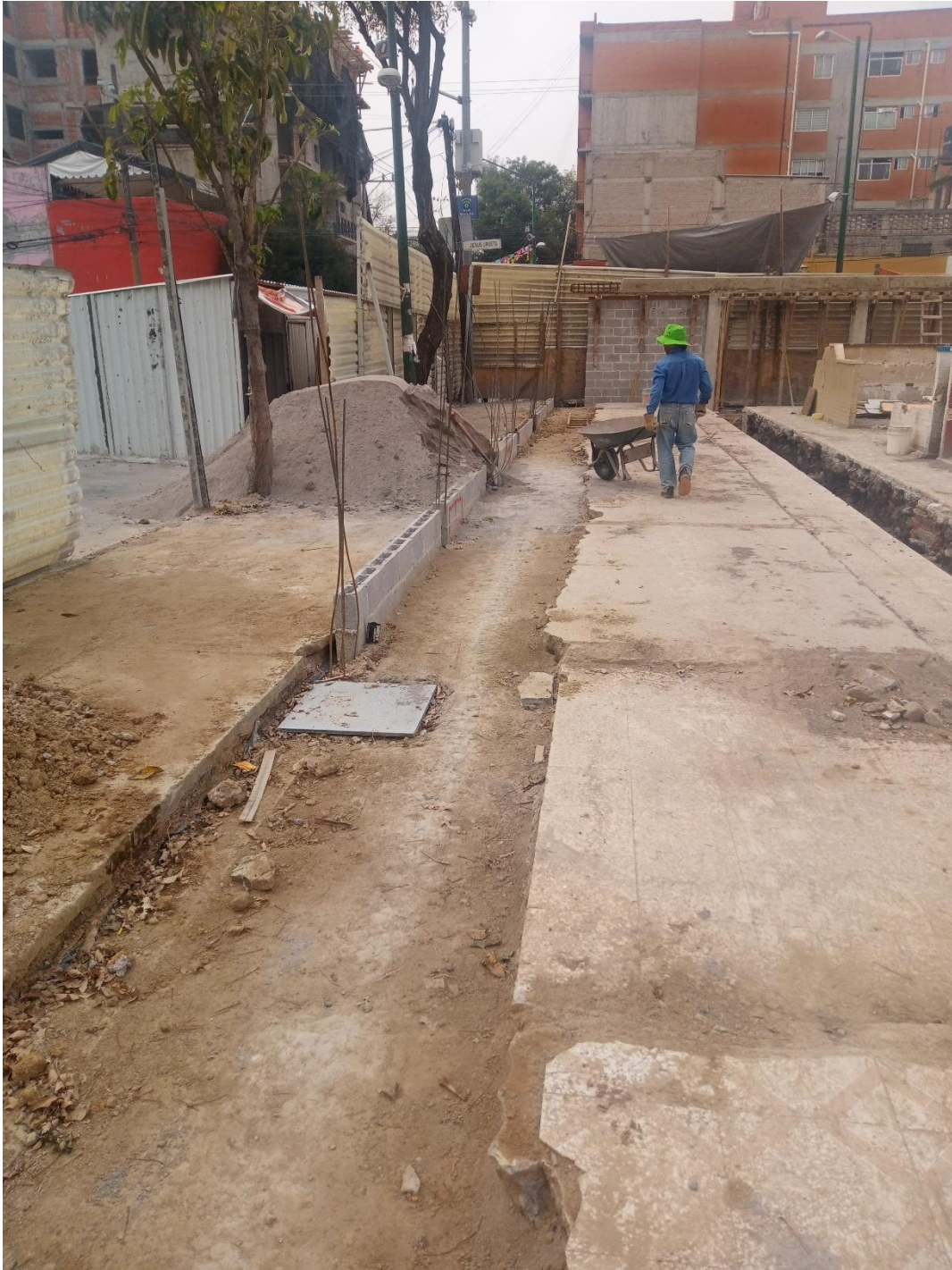
Relleno de zanja para cimentación con tezontle. Mercado la moderna.
