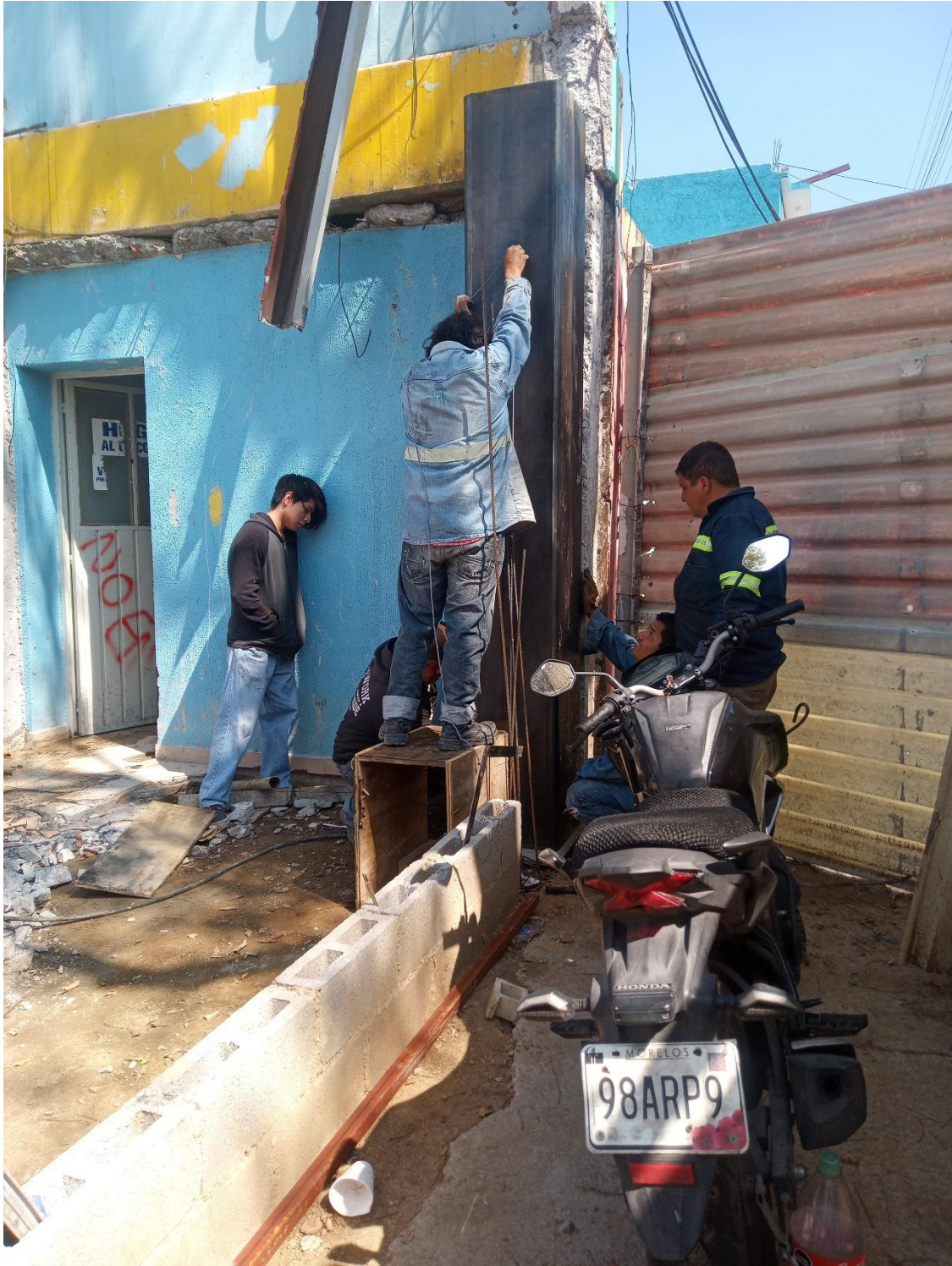
Colocación de columna de Ptr. Mercado la moderna.
