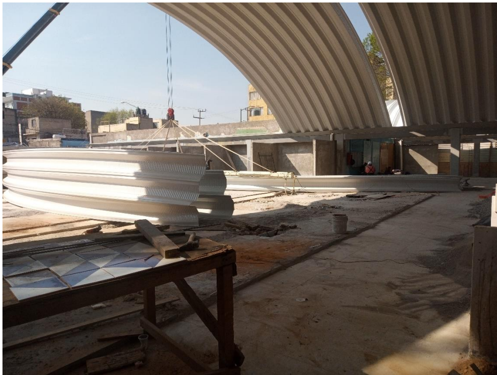
Colocación de cubierta de acero ligera ovoide. Mercado la moderna.
