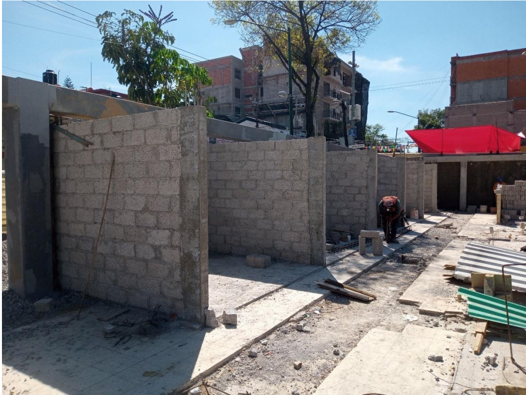
Muros limitantes de block para locales perimetrales. Mercado la moderna.
