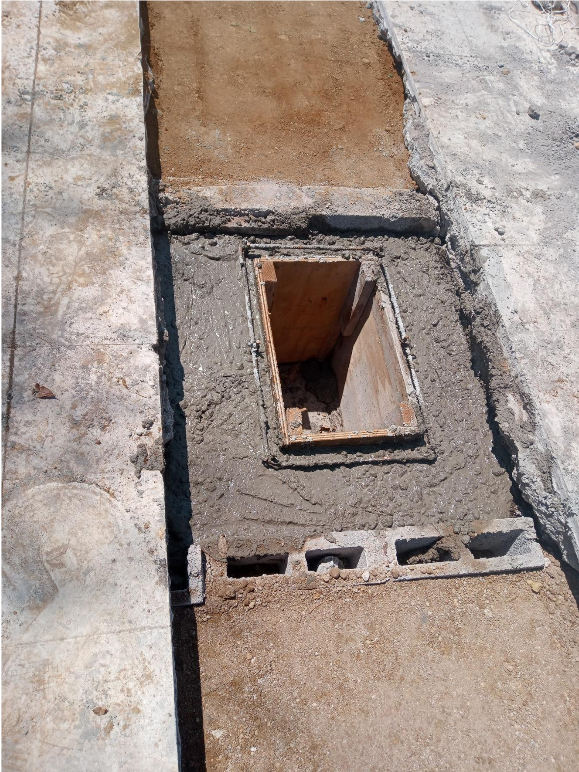
Relleno y apisonado de tezontle en zanja para instalación sanitaria. Mercado la moderna.
