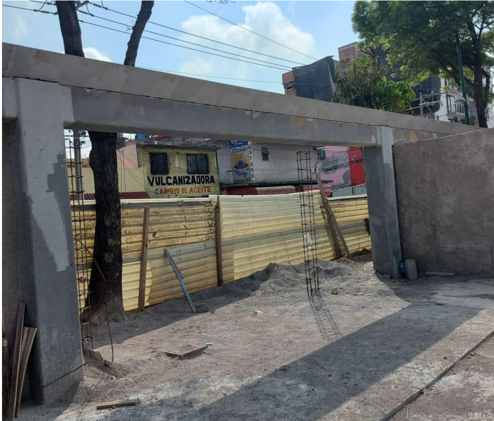
Aplicación de canaleta de acero para BAP. Mercado la moderna.
