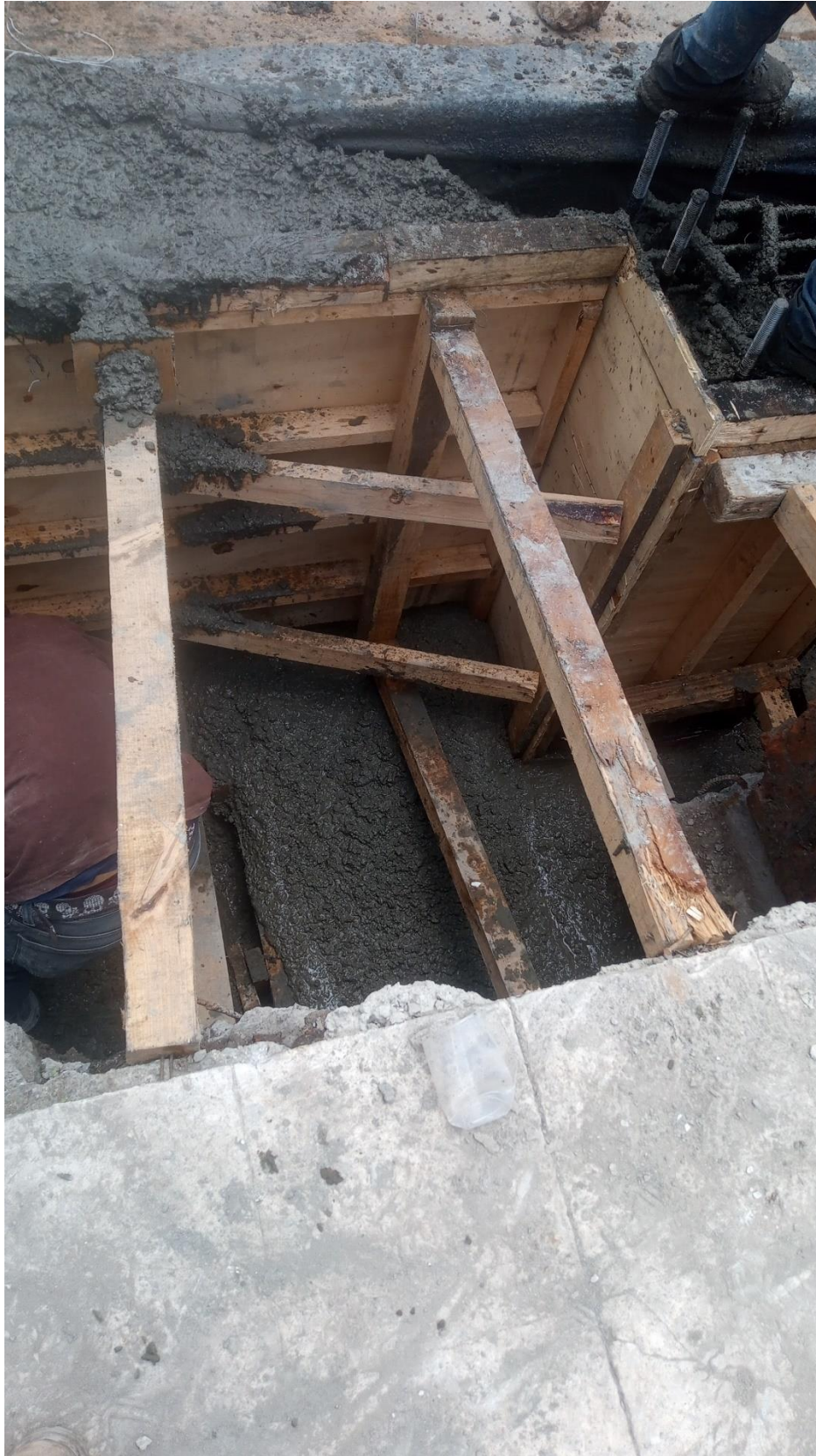
Colado de cimentación. Mercado la moderna.
