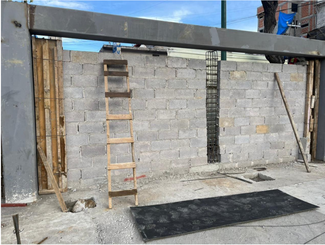
Muros perimetrales de block y cimbrado de castillos. Mercado la moderna.
