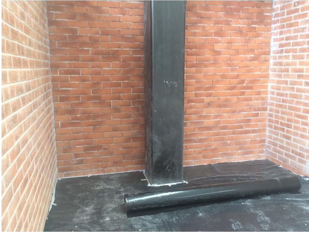
Columna de acero dentro de un local perimetral con acabado de ladrillo aparente. Mercado la moderna.
