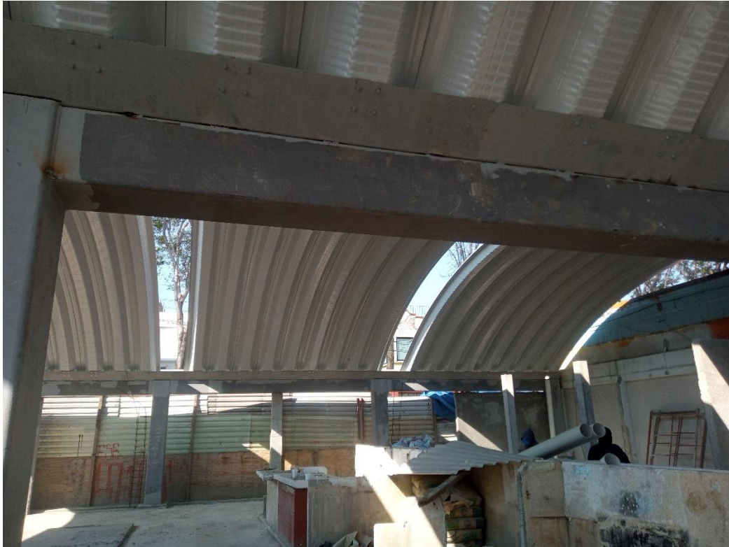
Unión de la cubierta con la canaleta para BAP. Mercado la moderna.
