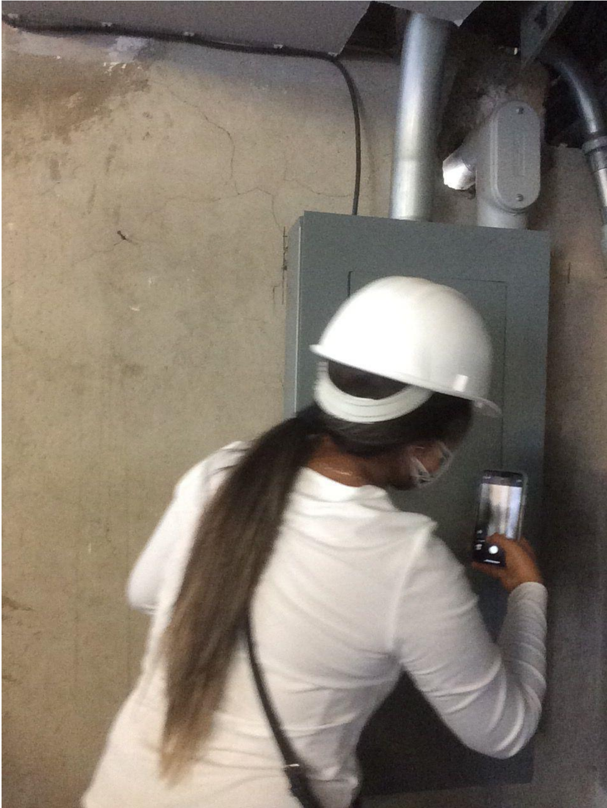
Revisión de fisuras en muros de concreto. Brigada post sismo.
