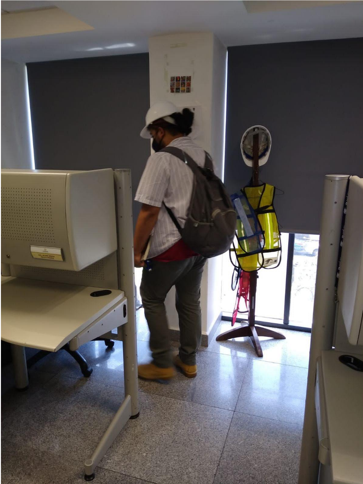
Exploración de columnas en oficinas. Brigada post sismo.
