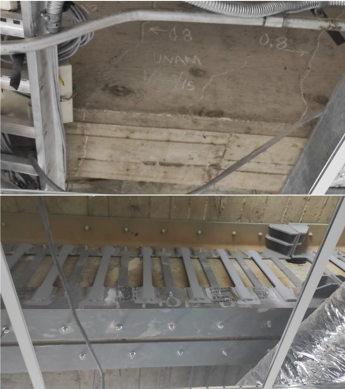
Inspección interior de loza de azotea. Brigada post sismo
