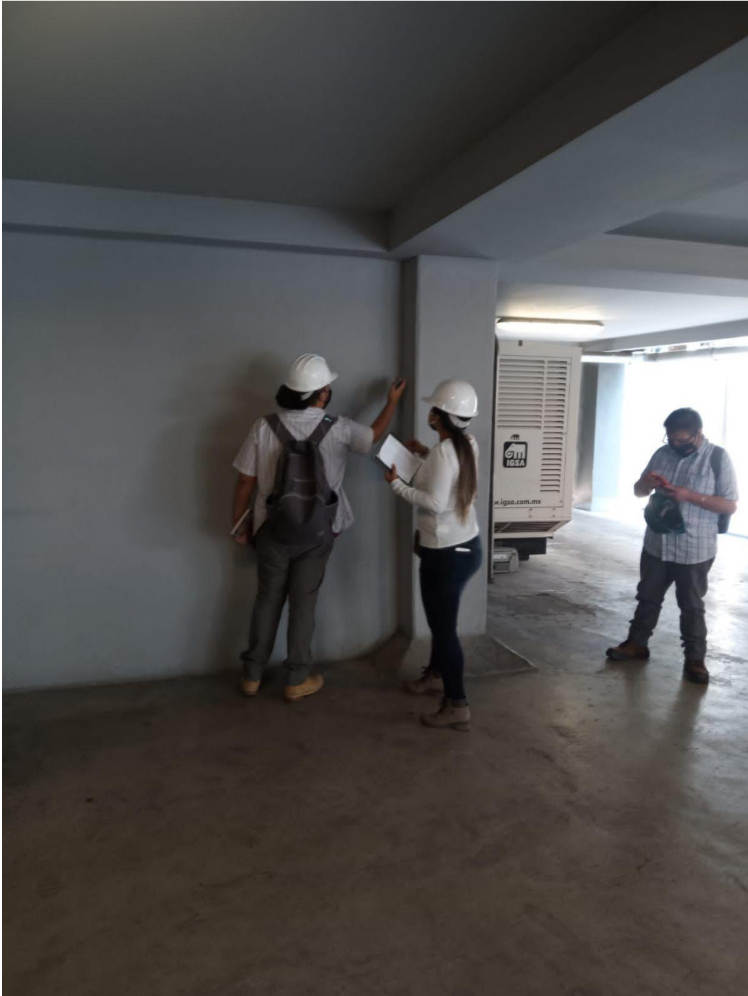
Revisión de estructura en estacionamiento. Brigada post sismo.
