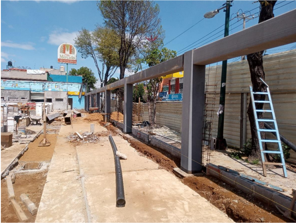
Primado de columnas y traves de acero. Mercado la moderna.
