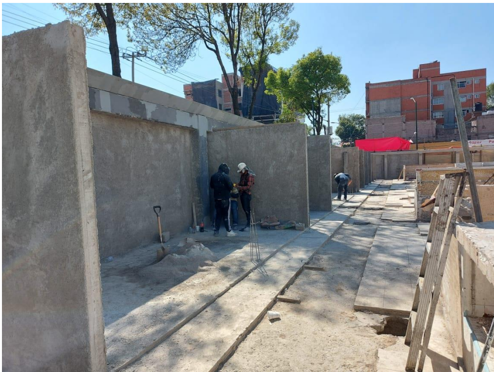
Repellado en muros perimetrales. Mercado la moderna.
