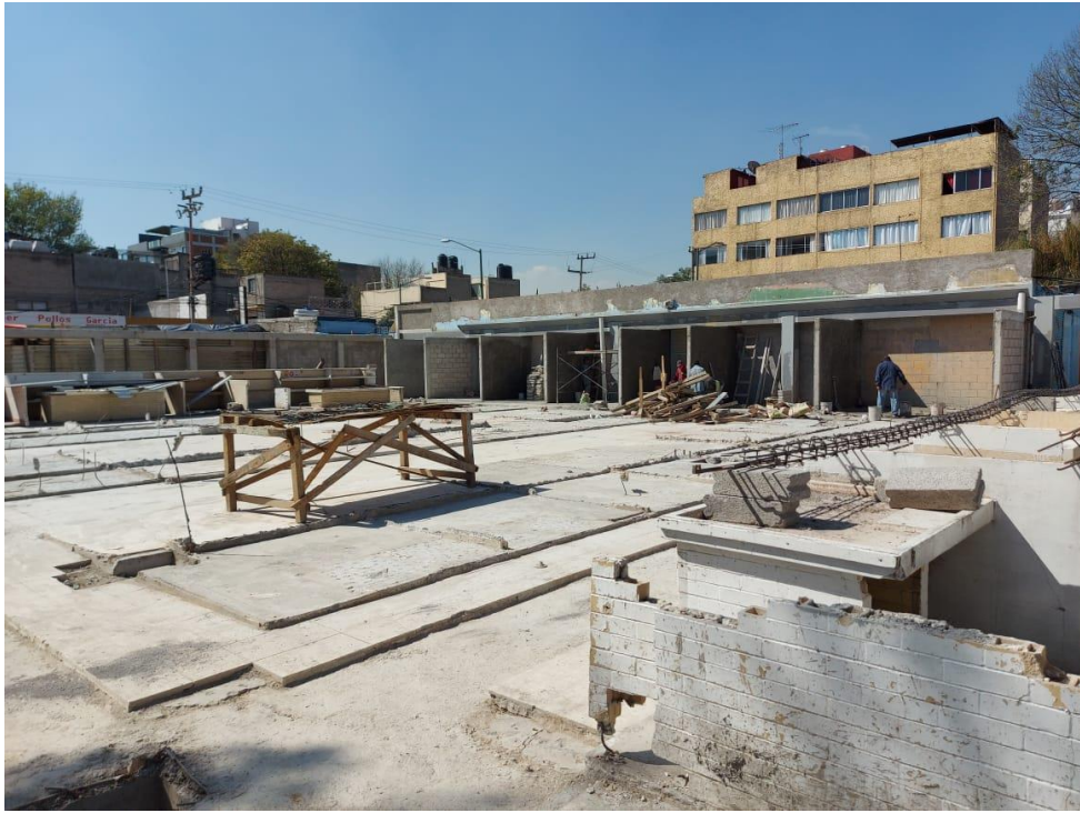
Demolición de locales originales. Mercado la moderna.
