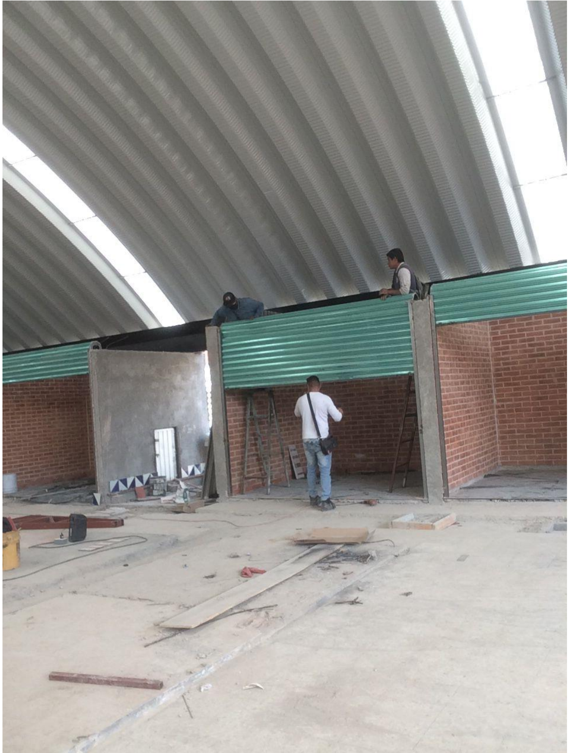
Colocación de cortinas de acero para locales perimetrales. Mercado la moderna.
