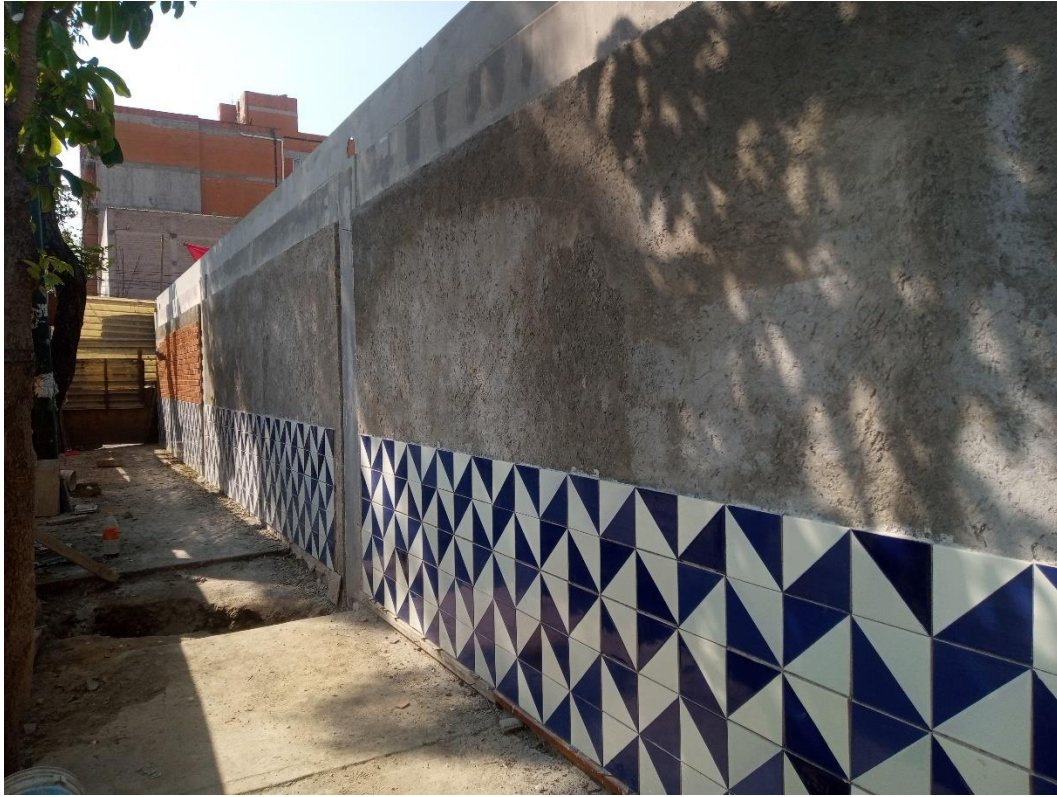
Aplicación de acabados de loseta en muros exteriores. Mercado la moderna.
