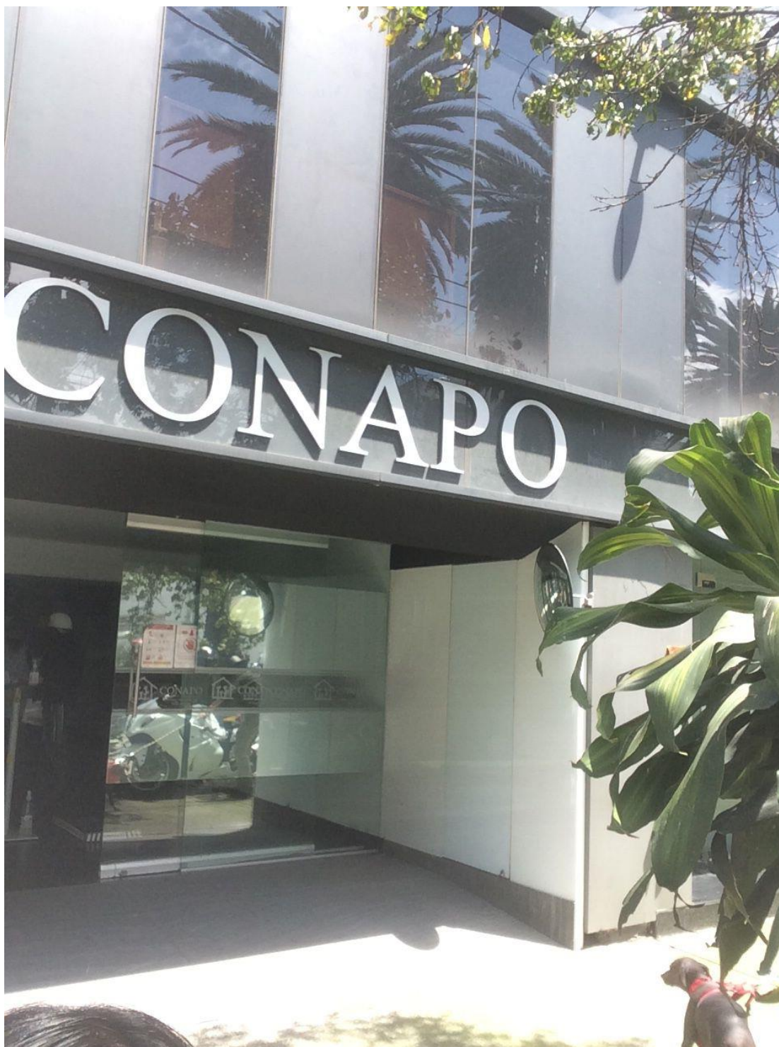
Ingreso al edificio de la CONAPO para inspección estructural. Brigada post sismo.
