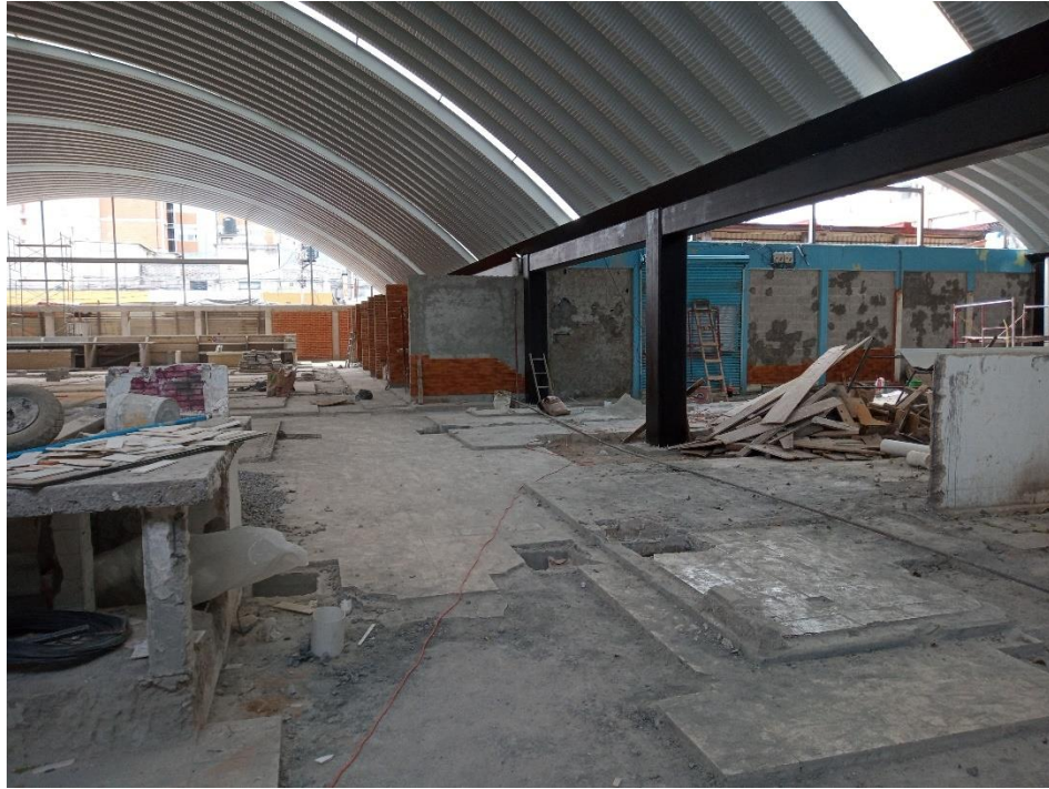
Eje central del mercado donde se ubican las columnas de acero. Mercado la moderna.
