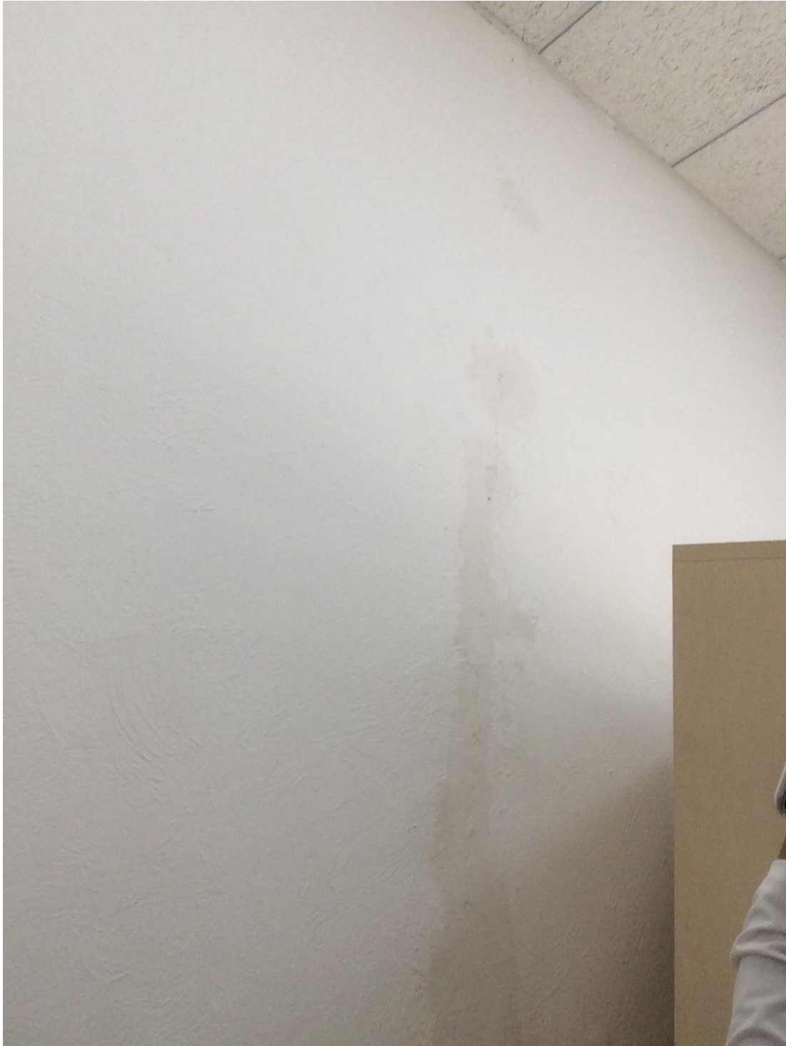
Resane de grietas con ready mix en oficinas. Brigada post sismo.
