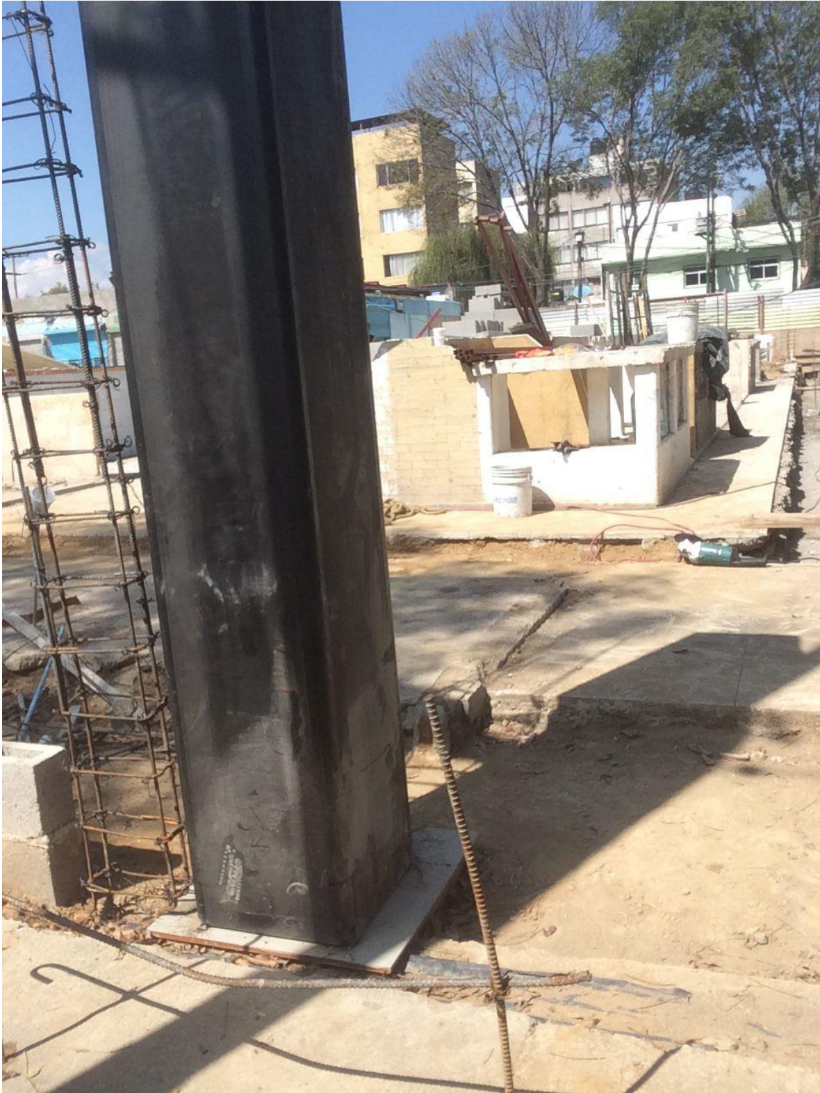
Columna de acero soldada en su placa junto a l armado de un castillo. Mercado la moderna.
