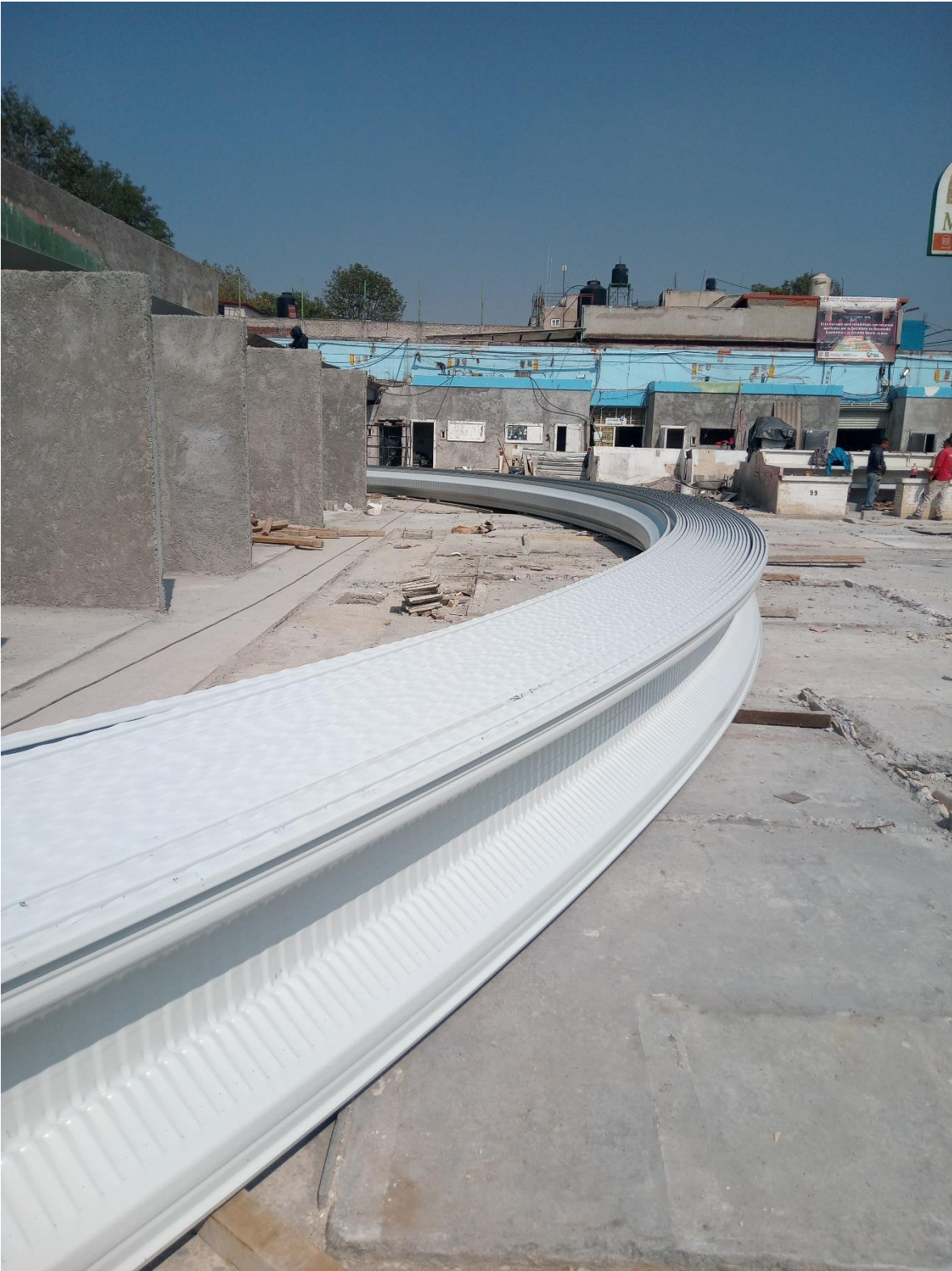
Piezas de acero para la cubierta ligera ovoide. Mercado la moderna.
