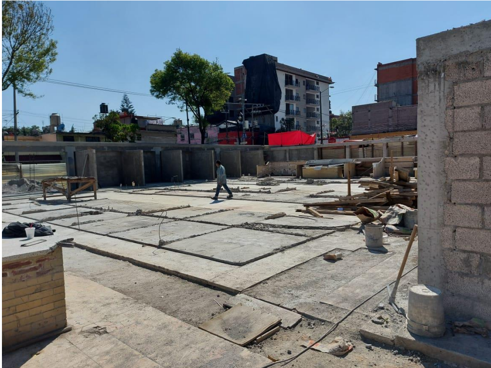
Demolición de locales originales desde otro ángulo. Mercado la moderna.
