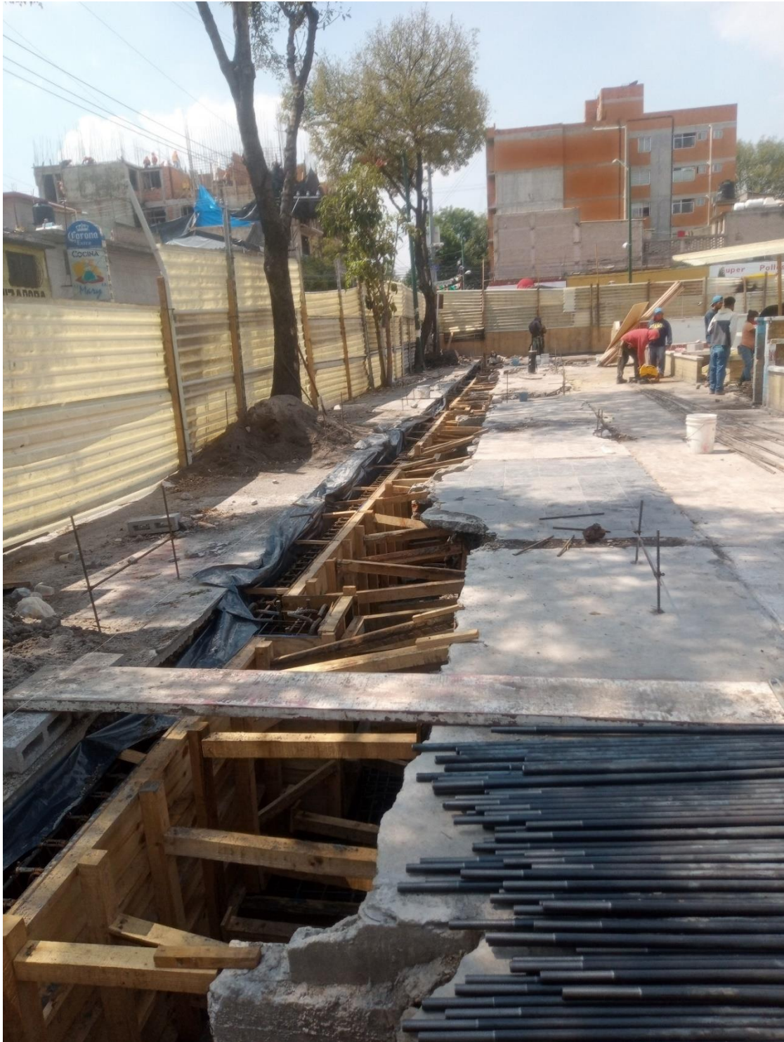
Armado y cimbrado de cimentación. Mercado la moderna.
