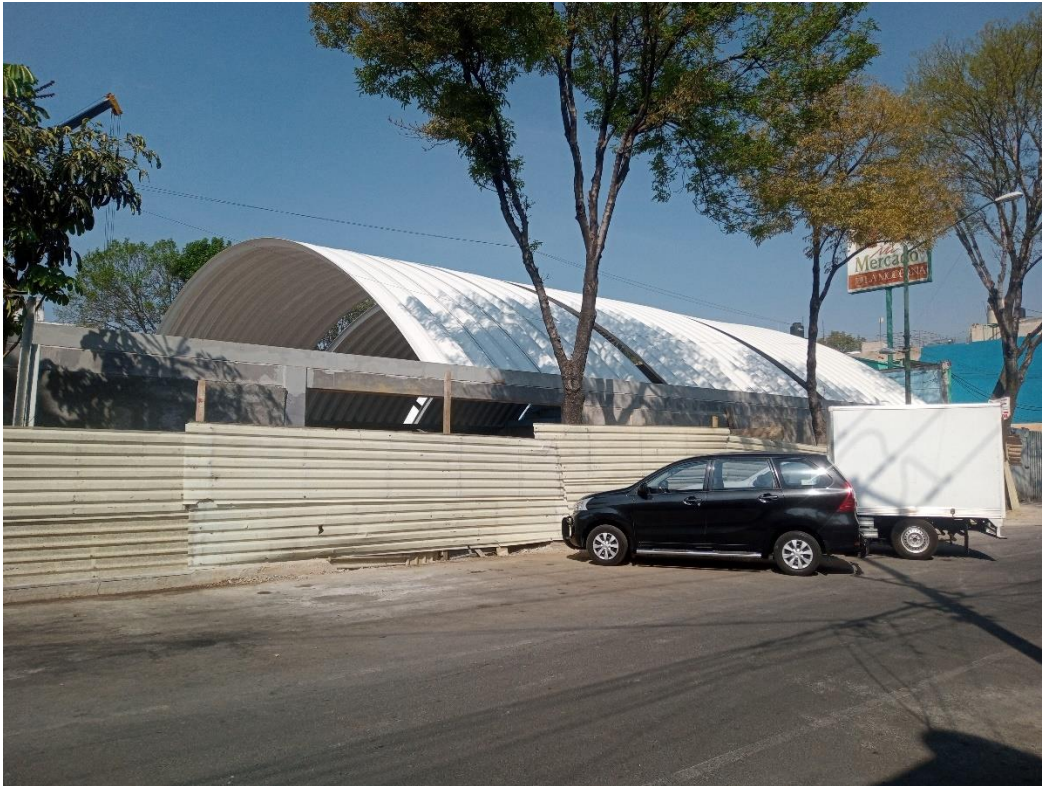
Colocación de cubierta ligera ovoide vista exterior. Mercado la moderna.
