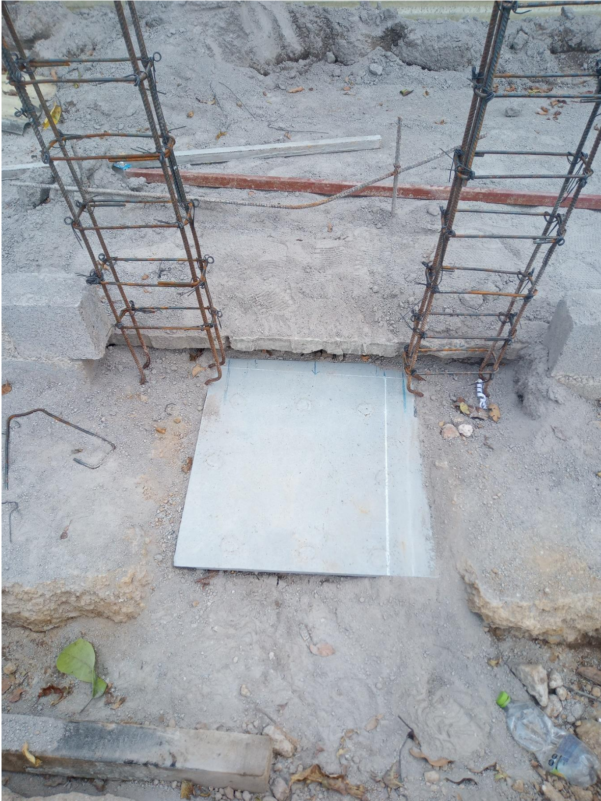
Castillos a los lados de la placa de acero para la columna de Ptr. Mercado la moderna.
