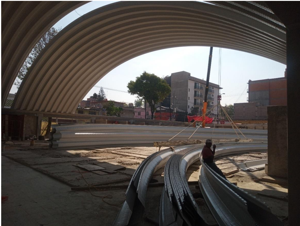
Aplicación de cubierta de acero ligera con grúa. Mercado la moderna.
