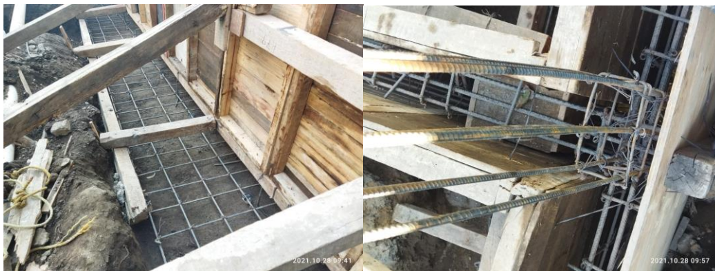
Imagen 13. Visita de obra en la alcaldía Tlalpan elaboración de zapatas
