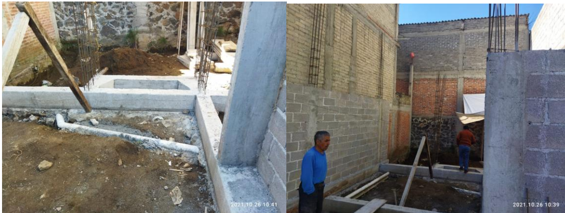
Imagen 11. Visita de obra en la alcaldía Tlalpan instalación sanitaria
