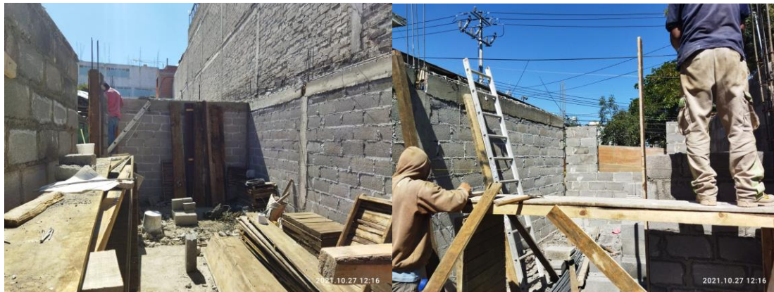
Imagen 12. Visita de obra en la alcaldía Tlalpan elaboración de muros
