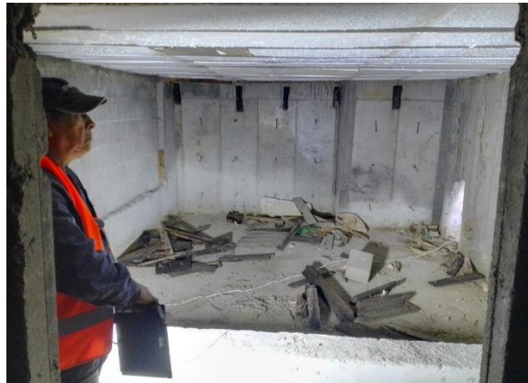
8. Revisión de cimentación
