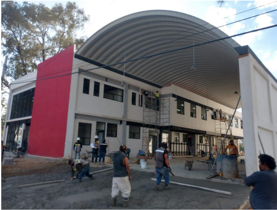
Anexo 1: levantamiento de detalles y construcción de la rampa de acceso para el “Heroico Cuerpo de Bomberos” en la Delegación Iztacalco.
