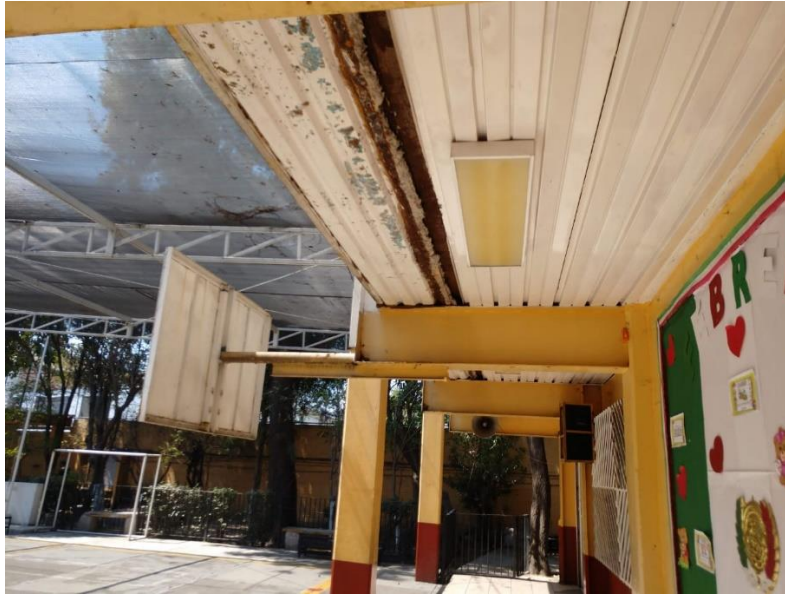
Anexo 5: Supervisión de avance y verificación de elementos estructurales, así como de acabados en “Escuela primaria” ubicada en la delegación Iztacalco.
