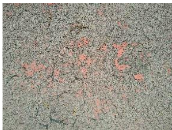
Imagen 28.- Impermeabilizante desgastado.
