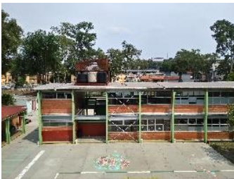
Imagen 30.- Vista de la escuela desde el techo de otro edificio.
