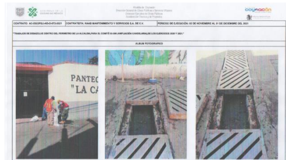
Imagen 9.- Colocación de rompe tormentas.
