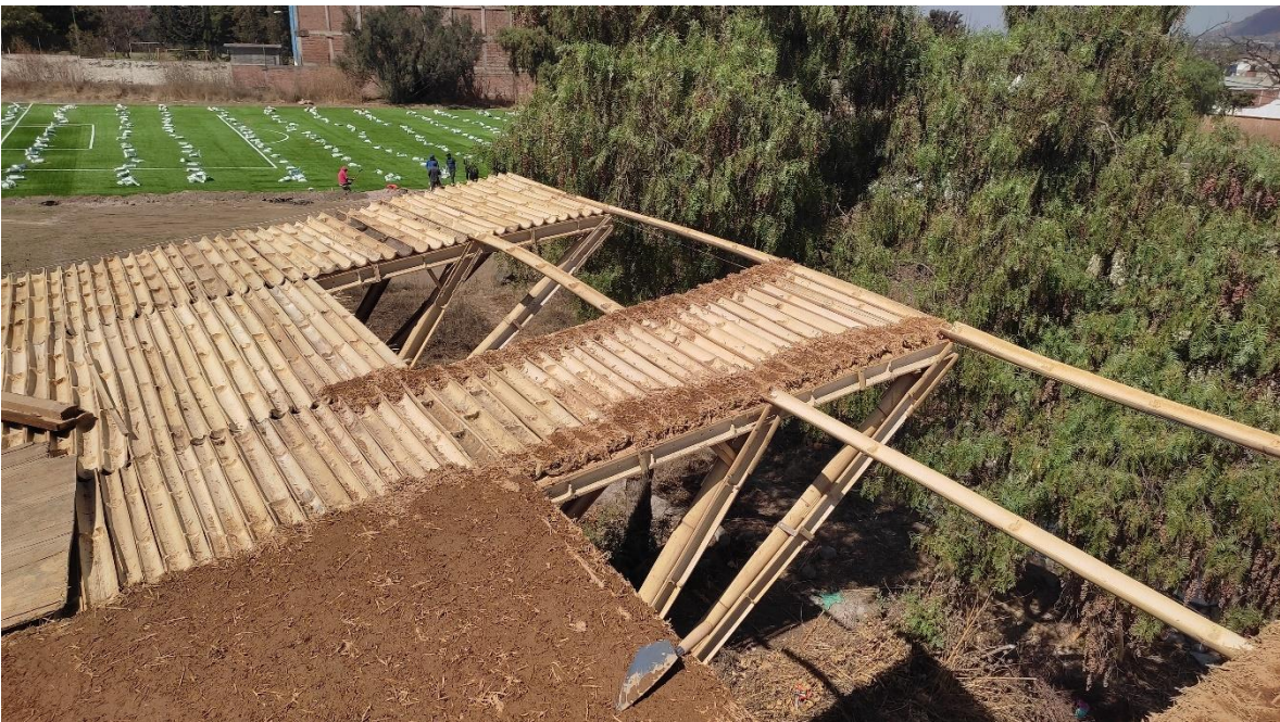
Ilustración 13. Colocación de capa de tierra en cubierta.
