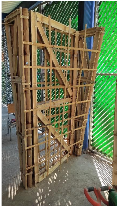
Ilustración 4. Armado de módulo de muro.
