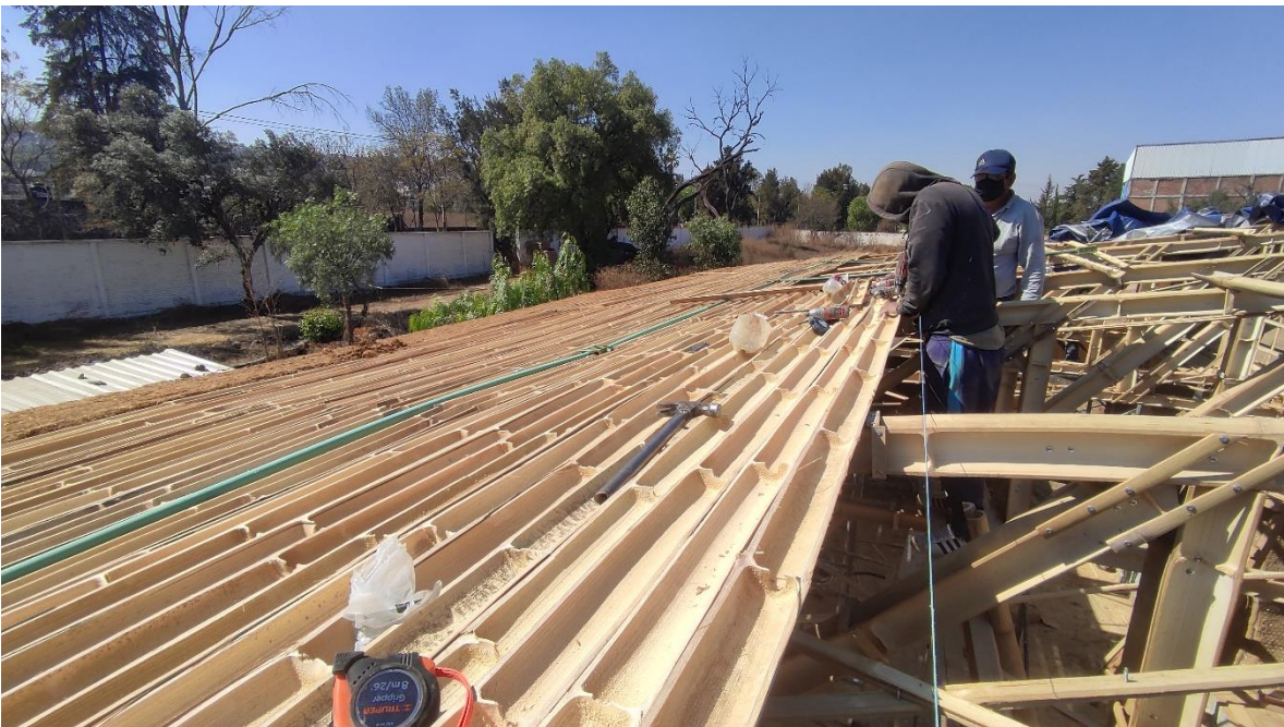
Ilustración 9. Tendido de bambús para cubierta.
