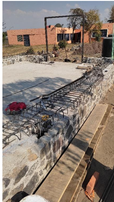
Ilustración 5. Armado de cadena de desplante para muros de bambú.
