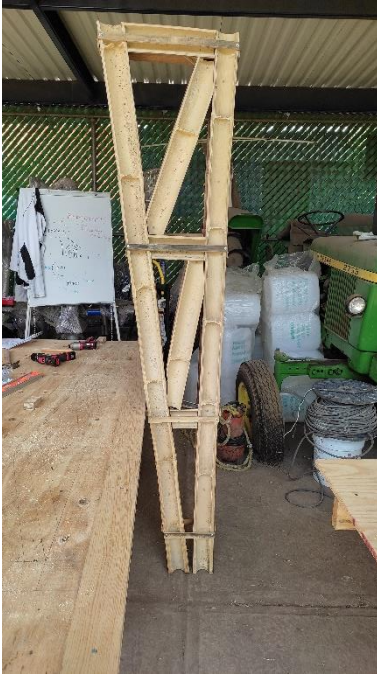
Ilustración 1. Primera armadura realizada.
