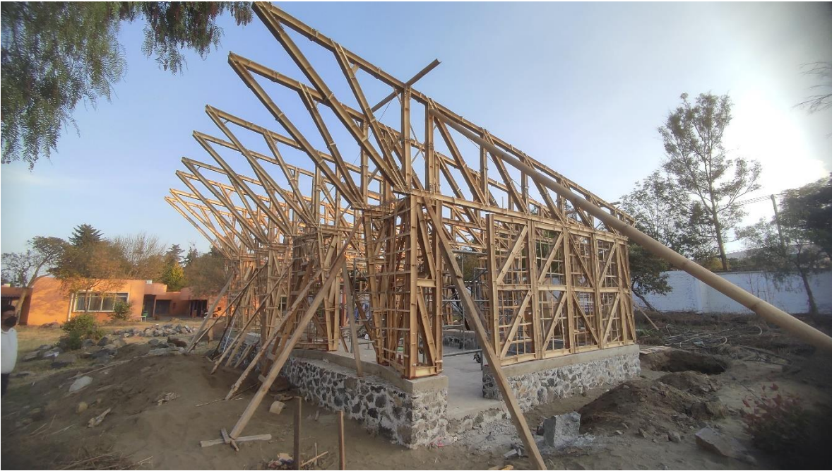
Ilustración 6. Colocación de estructura principal del aula.
