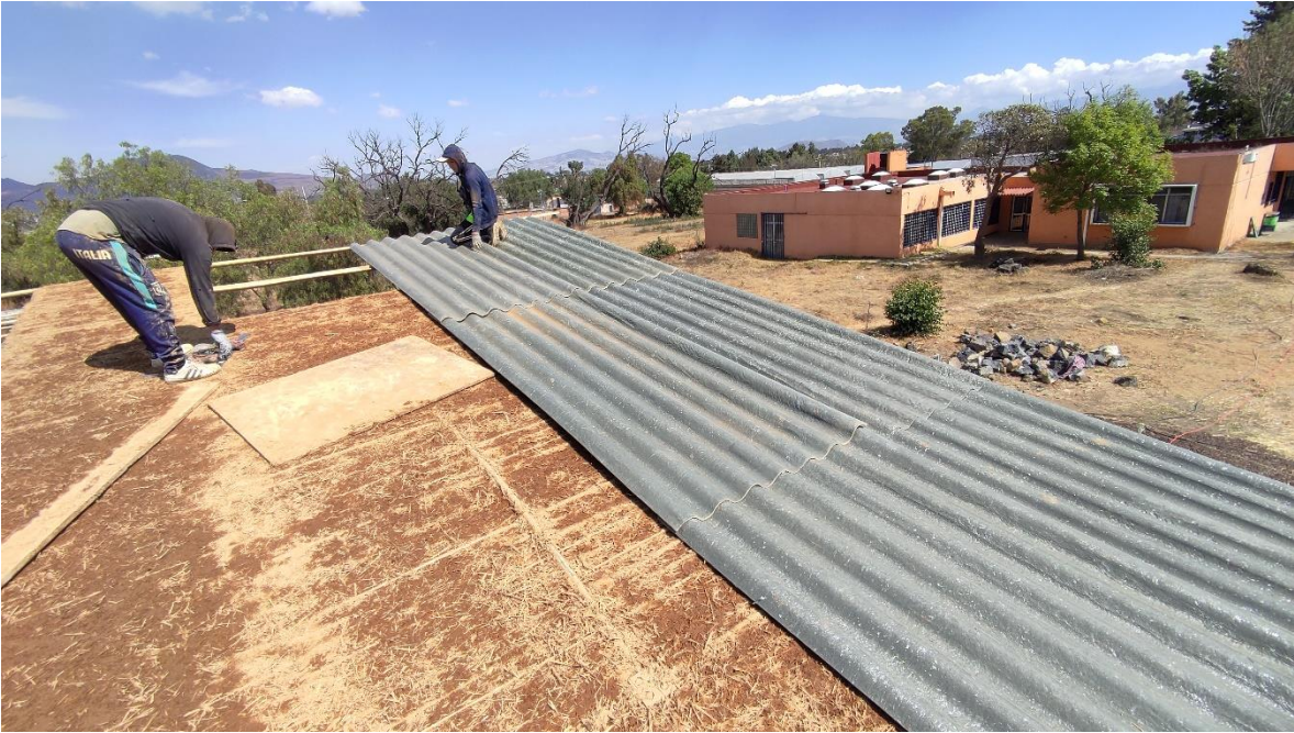
Ilustración 14. Colocación de lámina de polialuminio.
