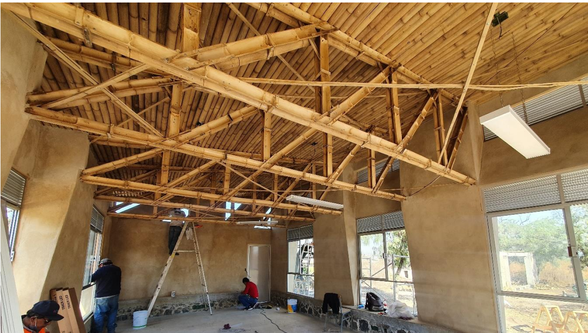
Ilustración 17. Instalación de luminarias.
