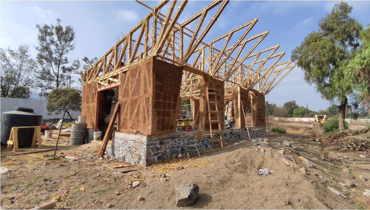
Ilustración 8. Aplanado de muros perimetrales: primera mano.
