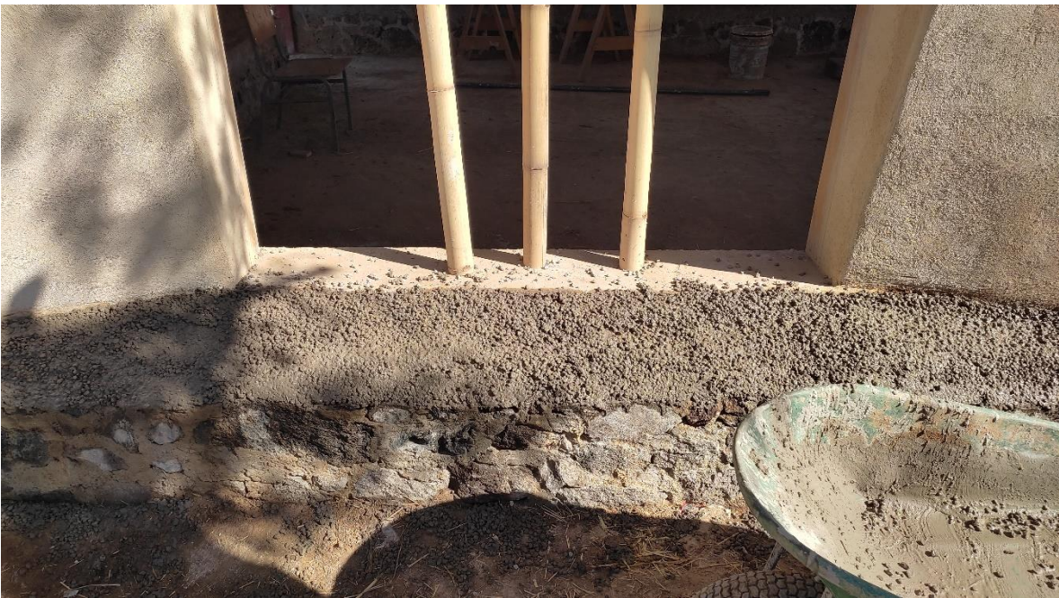
Ilustración 15. Talud con acabado deslavado.
