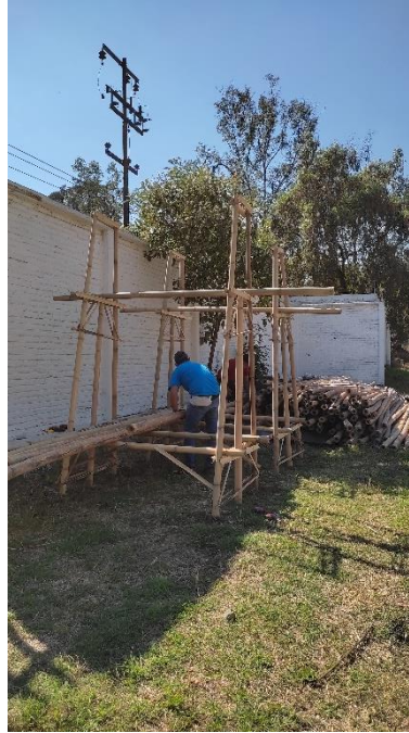
Ilustración 2. Construcción de almacén de bambú.
