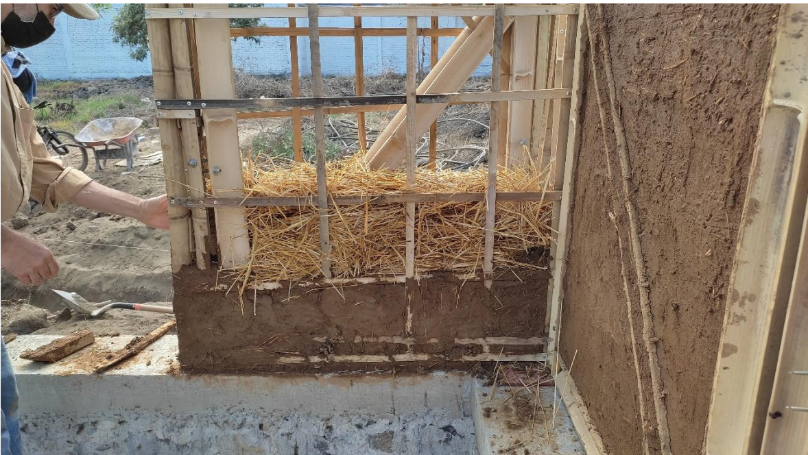
Ilustración 7. Firme de mezcla de tierra y relleno de muros con paja.
