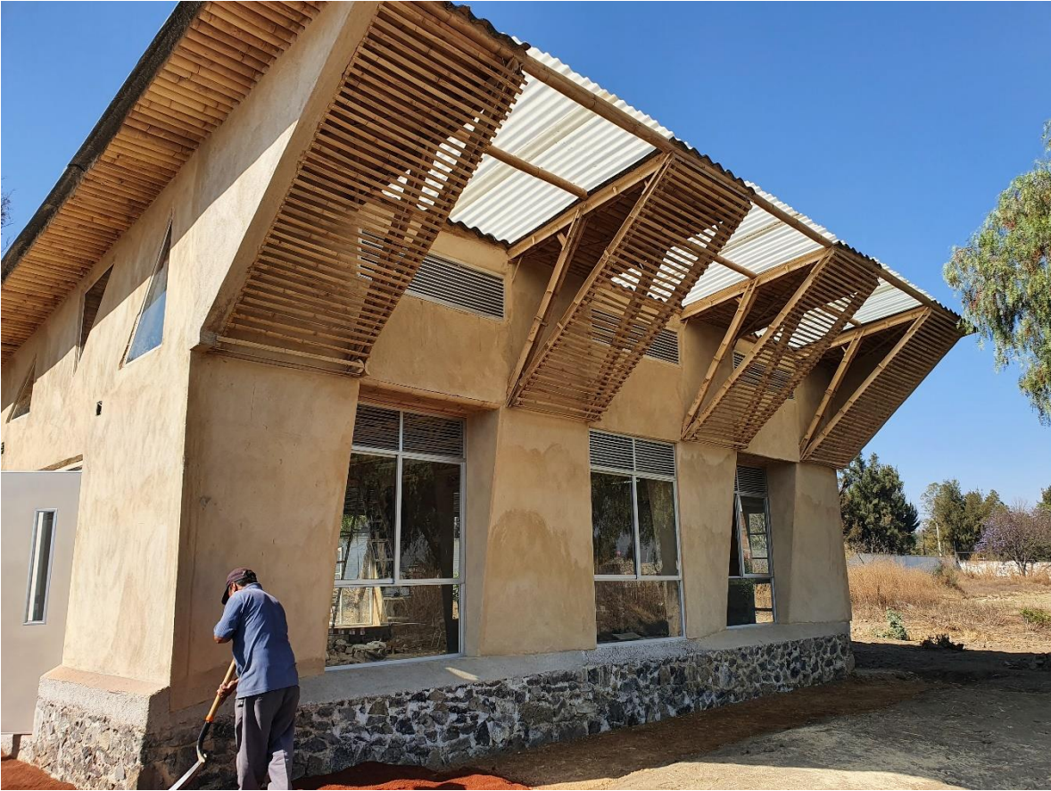
Ilustración 18. Celosía con latillas en fachada.
