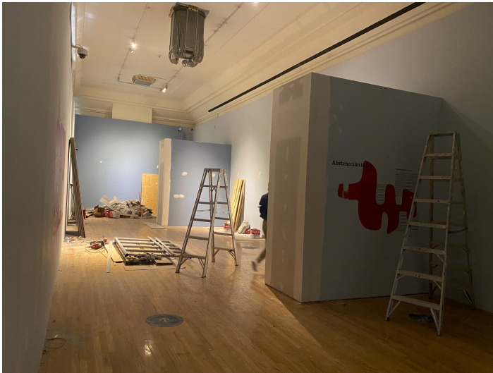
Imagen 1. Supervisión de procesos de demolición
