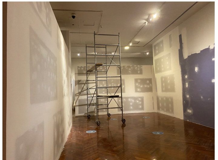
Imagen 4. Trabajos de tablaroqueros
