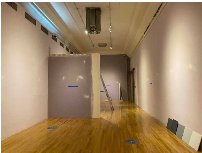
Imagen 5. Preparación de muros para pintura
