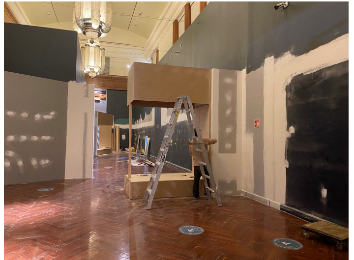
Imagen 2. Trabajos de carpinteros
